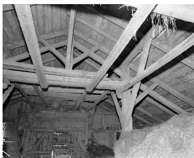
Intérieur : charpente du bâtiment annexe. Phot. Dominique Humbert IVR43_19762500562X
