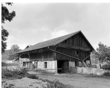
Extérieur : bâtiment annexe. Phot. Dominique Humbert IVR43_19762500556X
