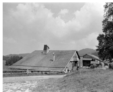
Extérieur : façades sud et est. Phot. Dominique Humbert IVR43_19762500555X
