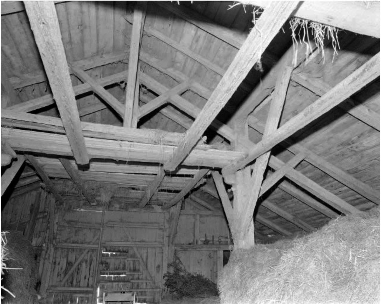
Intérieur : charpente du bâtiment annexe.
