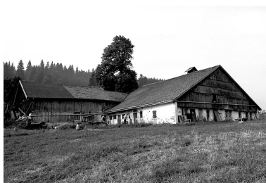
Vue d'ensemble, face nord. Phot. Dominique Humbert IVR43_19762500553X
