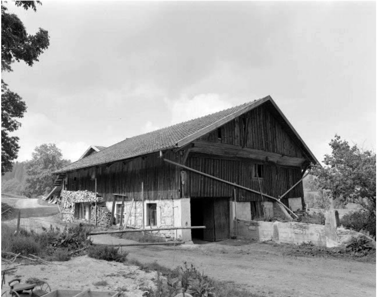
Extérieur : bâtiment annexe.
