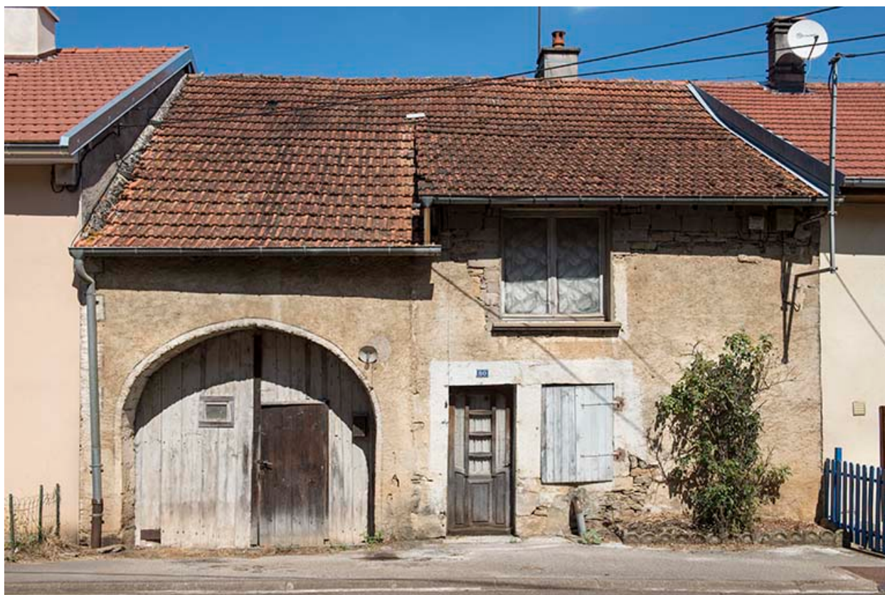
Ferme-bloc à deux travées.
