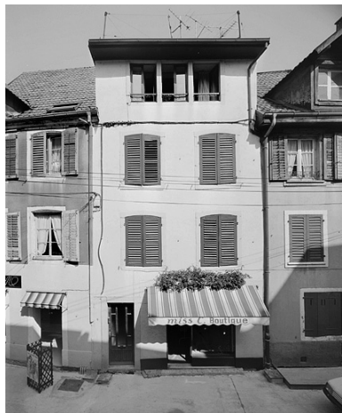
Façade sur rue. Phot. Jérôme Mongreville IVR43_19872501085V
