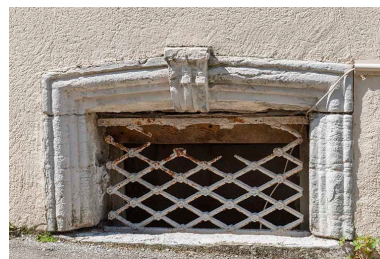
Façade antérieure. Soupirail. Phot. Jérôme Mongreville IVR43_20233900731NUC4A
