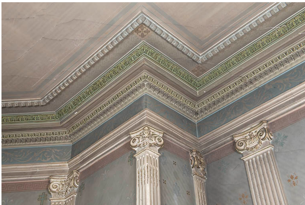
Détail des corniches du chœur.
