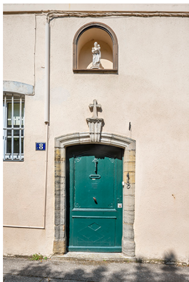
Façade antérieure. Entrée. Phot. Jérôme Mongreville IVR43_20233900734NUC4A
