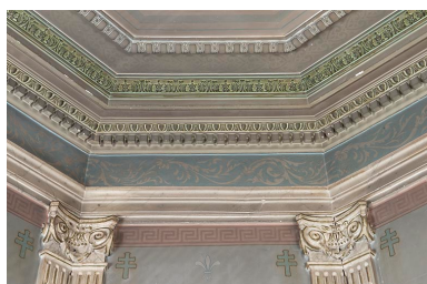
Partie supérieure du chevet de la chapelle. Phot. Jérôme Mongreville IVR43_20243900868NUC4A
