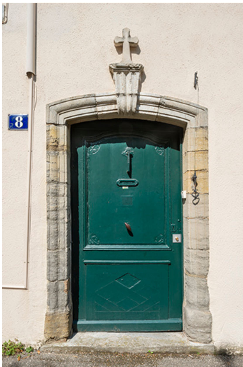
Façade antérieure. Détail de la porte.
