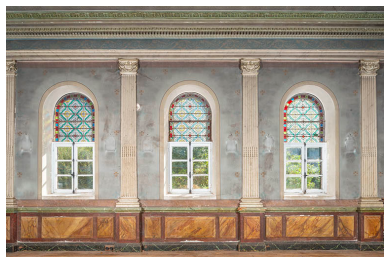
Façade est de la chapelle. Phot. Jérôme Mongreville IVR43_20243900865NUC4A
