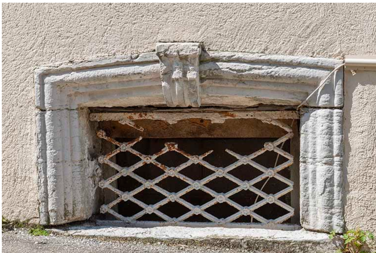
Façade antérieure. Soupirail.
