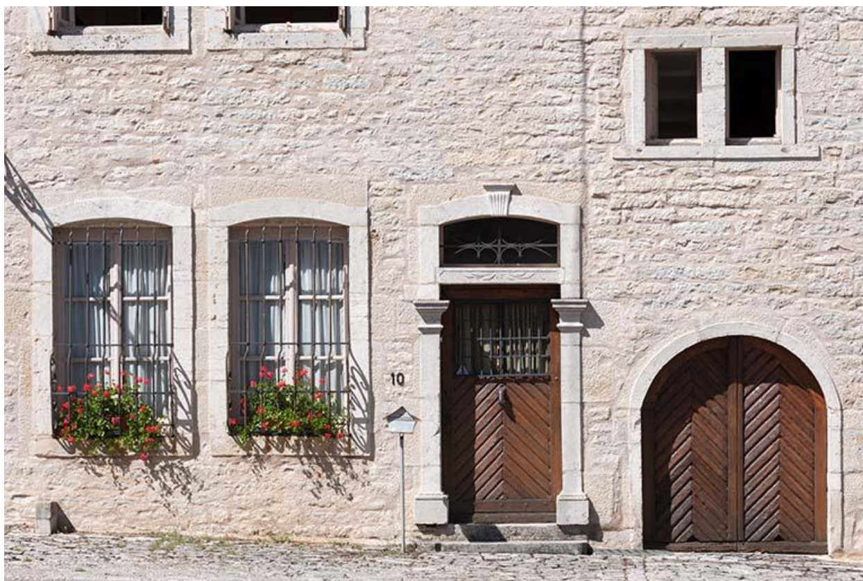
Détail des baies de la façade sud
