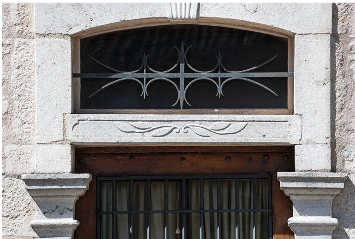
Détail de l'imposte au-dessus de la porte
