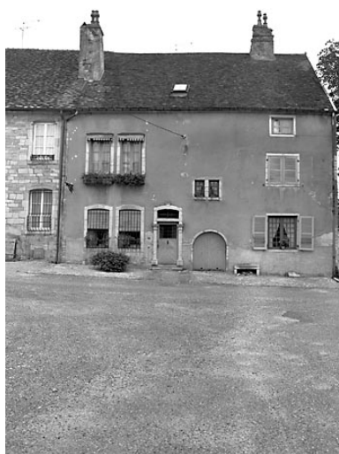
Façade antérieure. Phot. Dominique Dominguez IVR43_19807000549X
