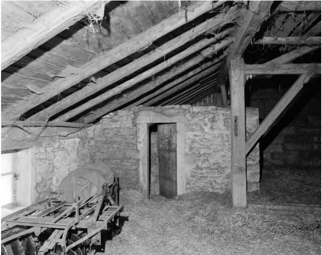
Intérieur : le "grenier"maçonné.
