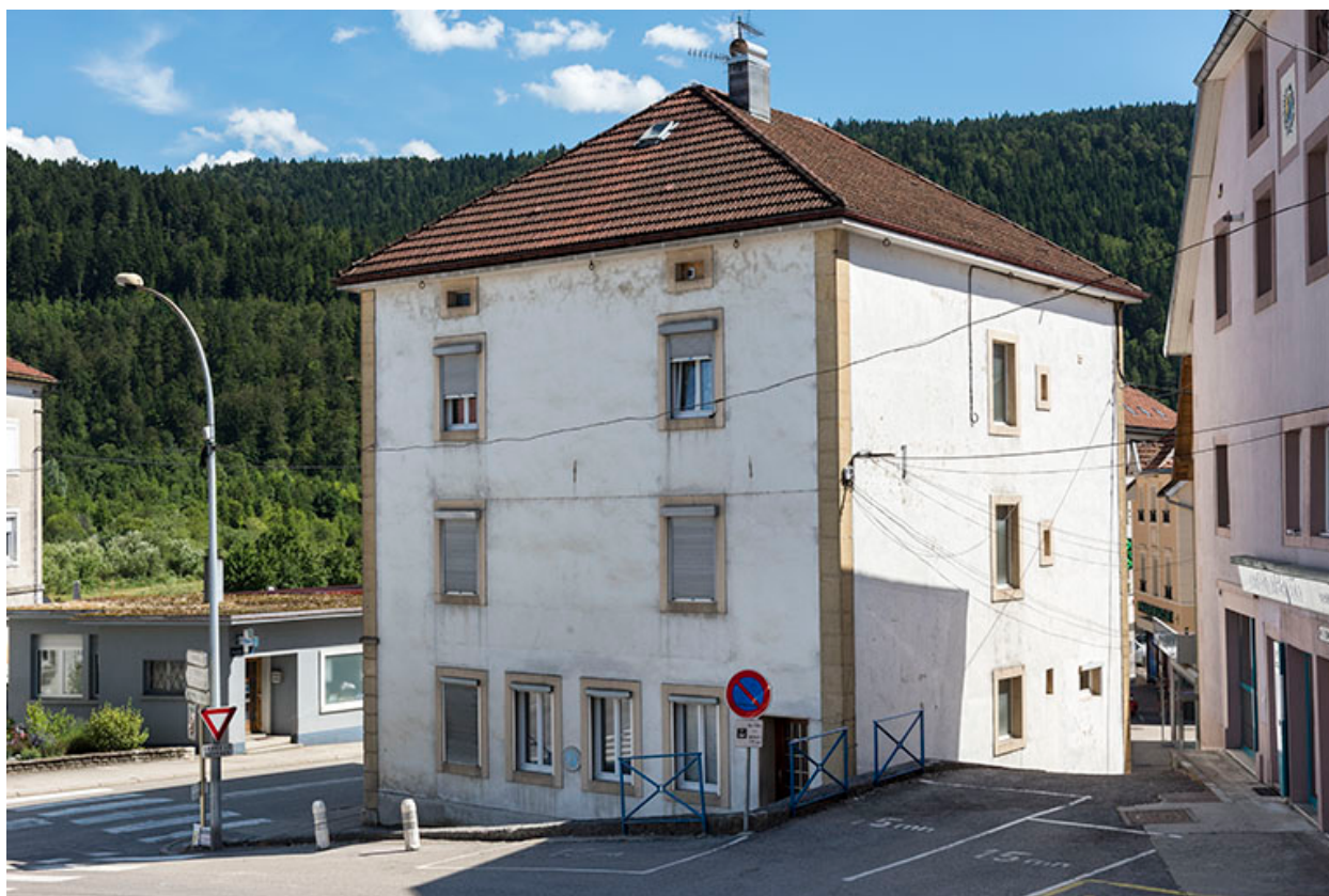
Façades postérieure et latérale droite.
