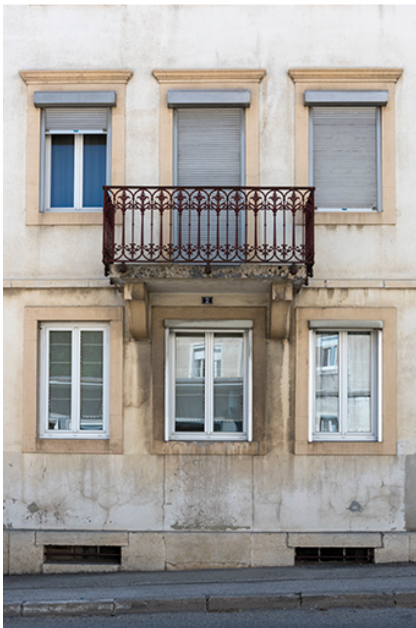
Façade antérieure : travées centrales.
