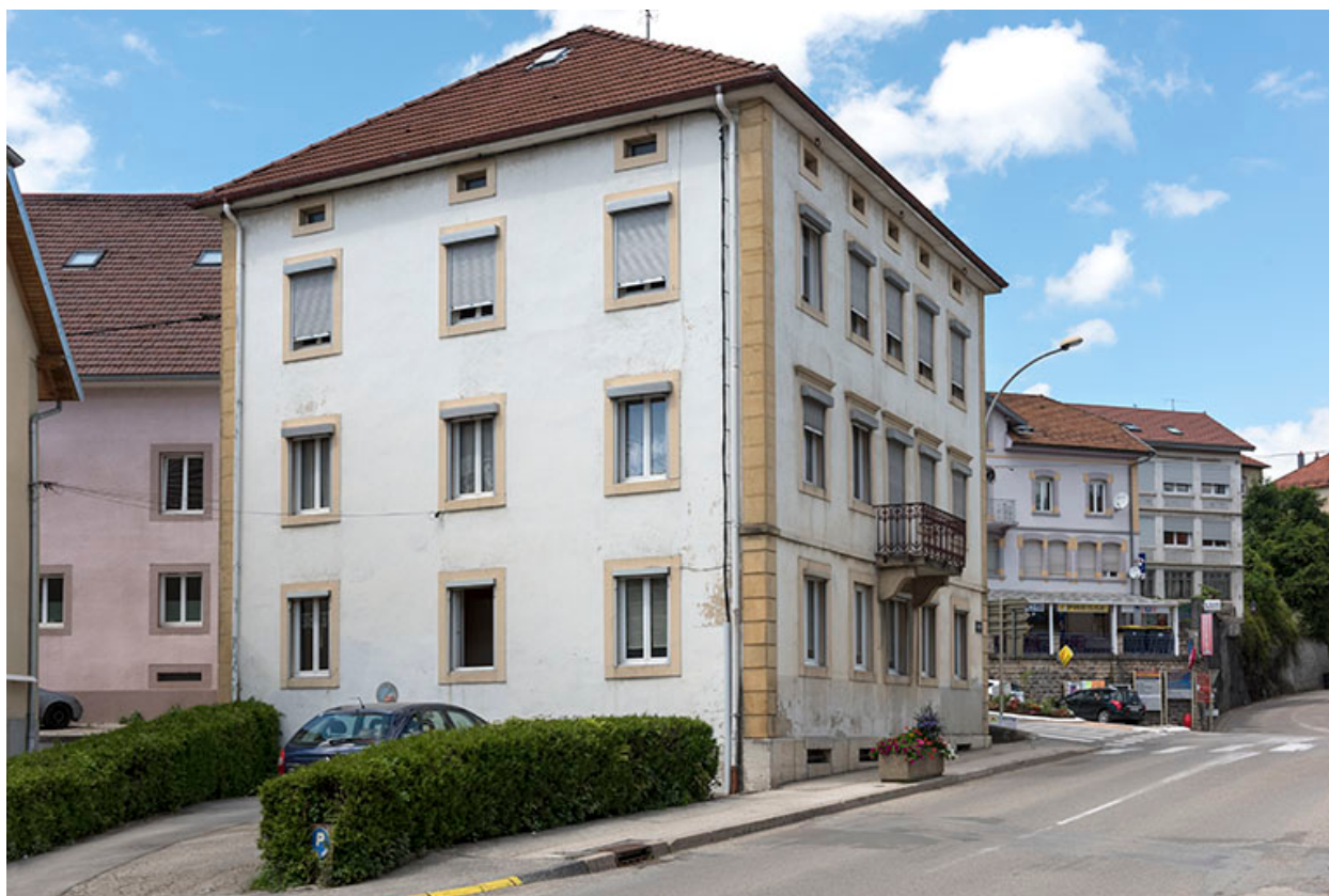
Façades antérieure et latérale gauche.
