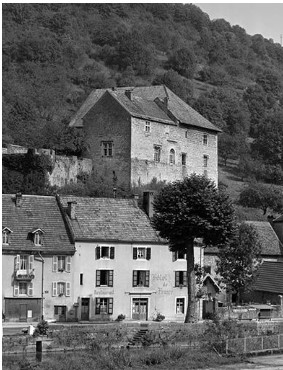
Vue générale, angle sud-ouest.
