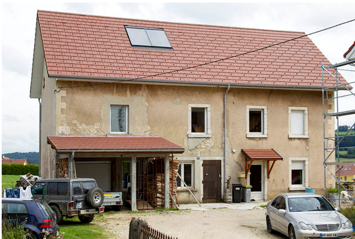
Bâtiment au n° 39 : façade antérieure.
