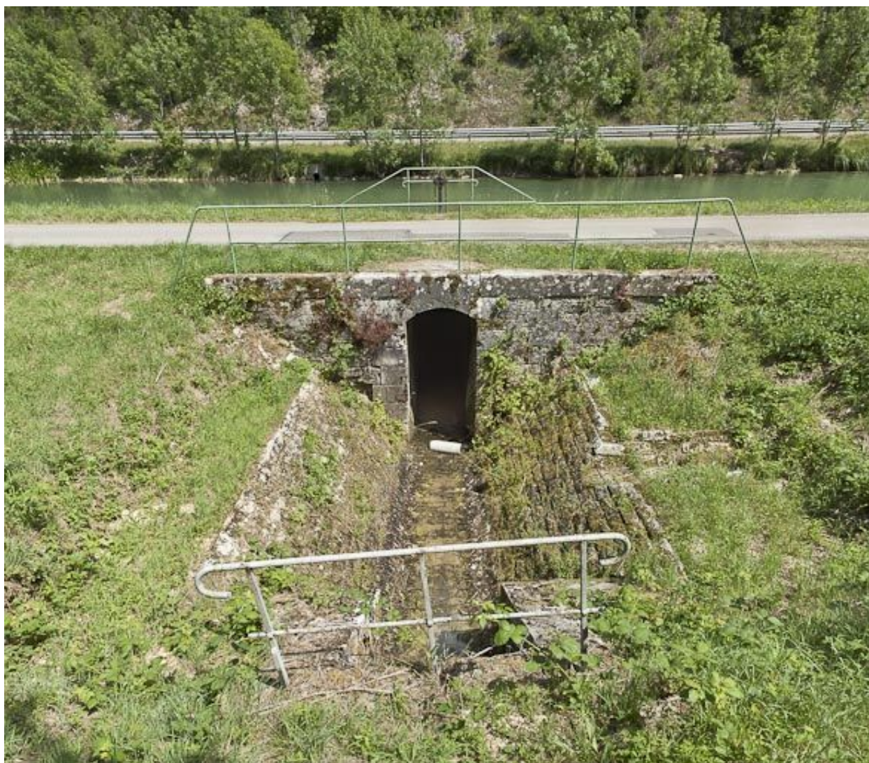
Vue du déversoir et de sa rigole en maçonnerie.
