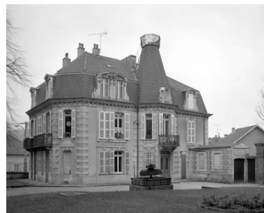
Bureaux dits château Béthanie. Phot. Yves Sancey IVR43_19973900519X
