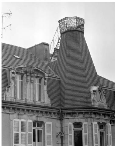
Château Béthanie : toiture de la tourelle d'escalier. Phot. Yves Sancey IVR43_19973900522X
