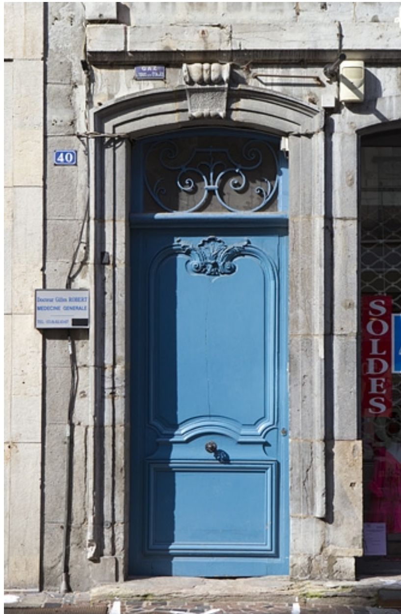
Détail de la porte du couloir d'entrée.
