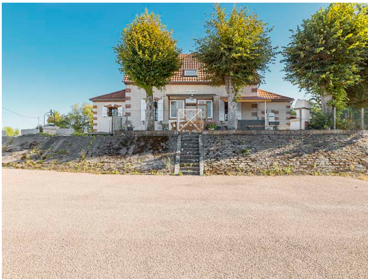
Vue d'ensemble de la maison du barragiste.
