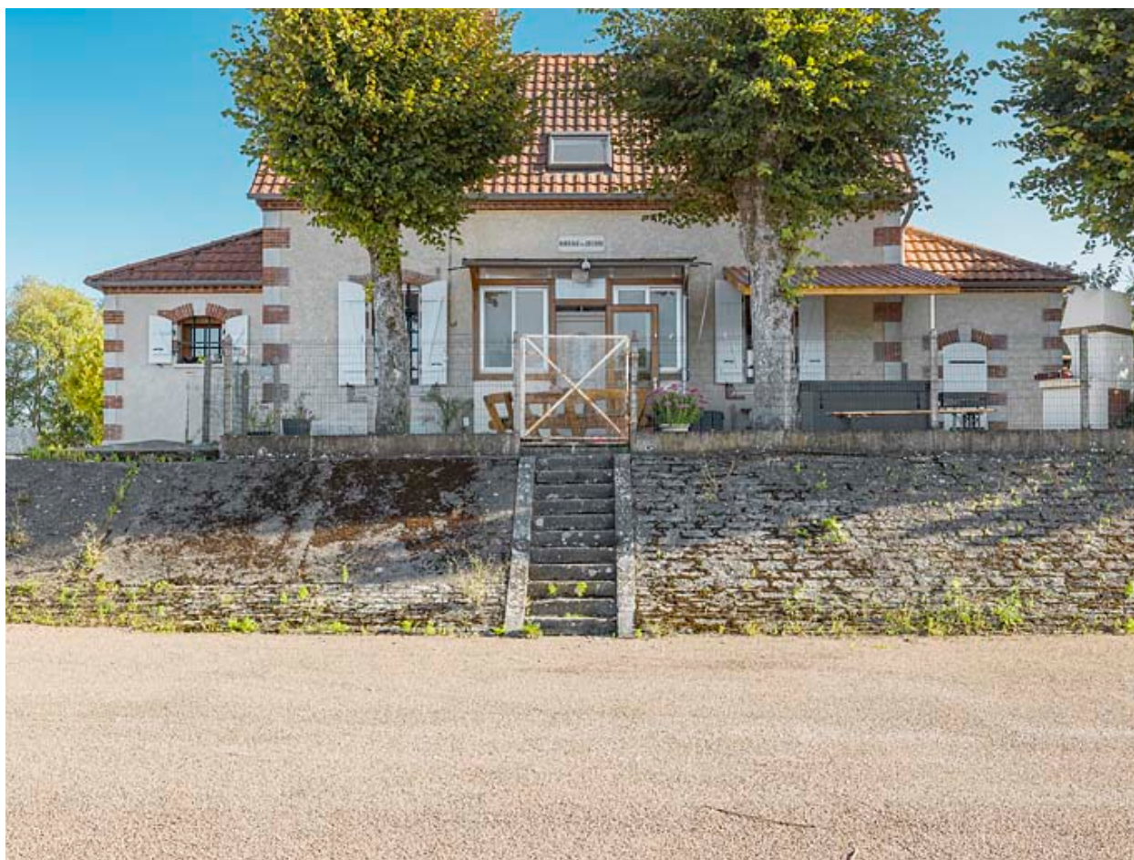
Vue d'ensemble de la maison du barragiste.
