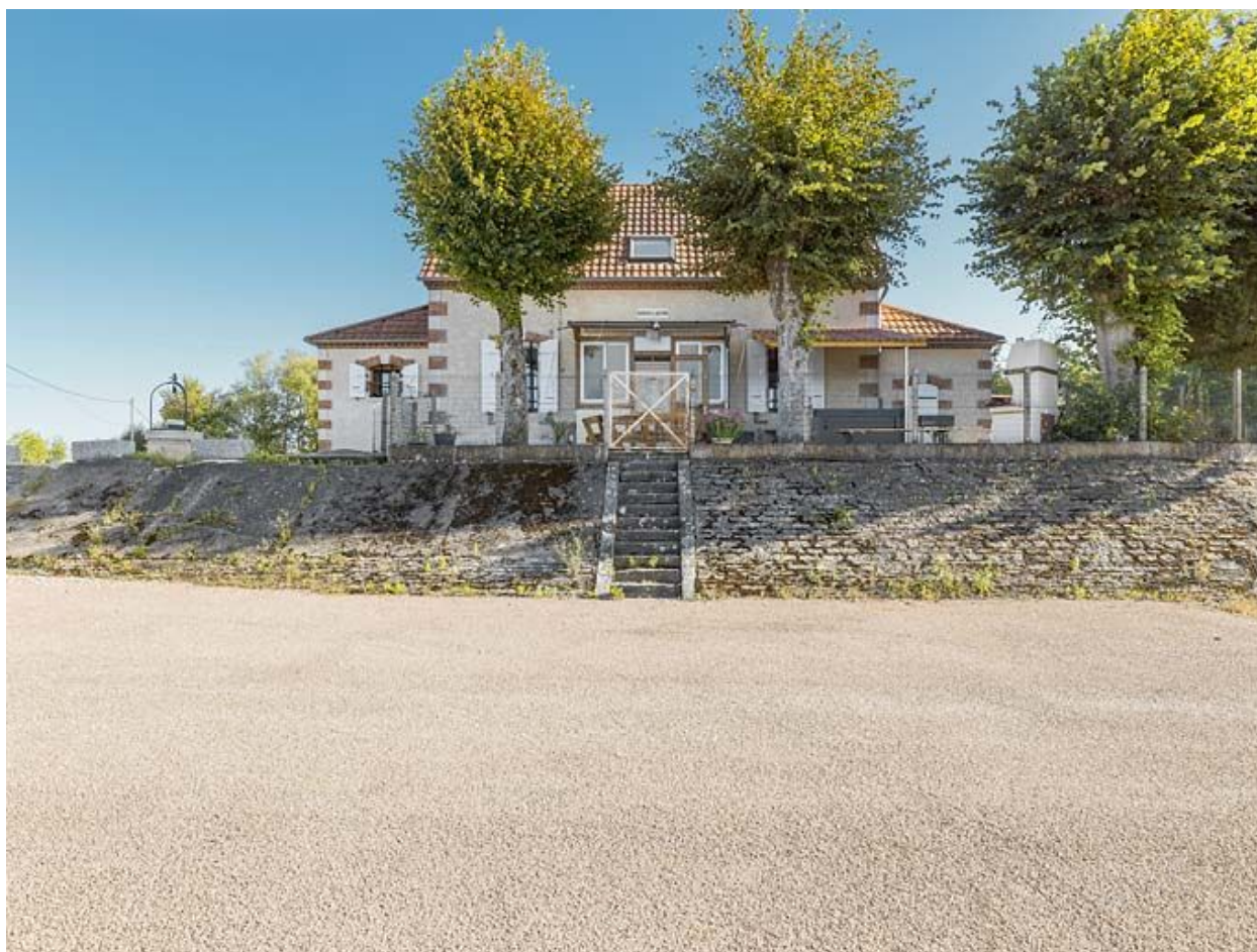
Vue d'ensemble de la maison du barragiste.
