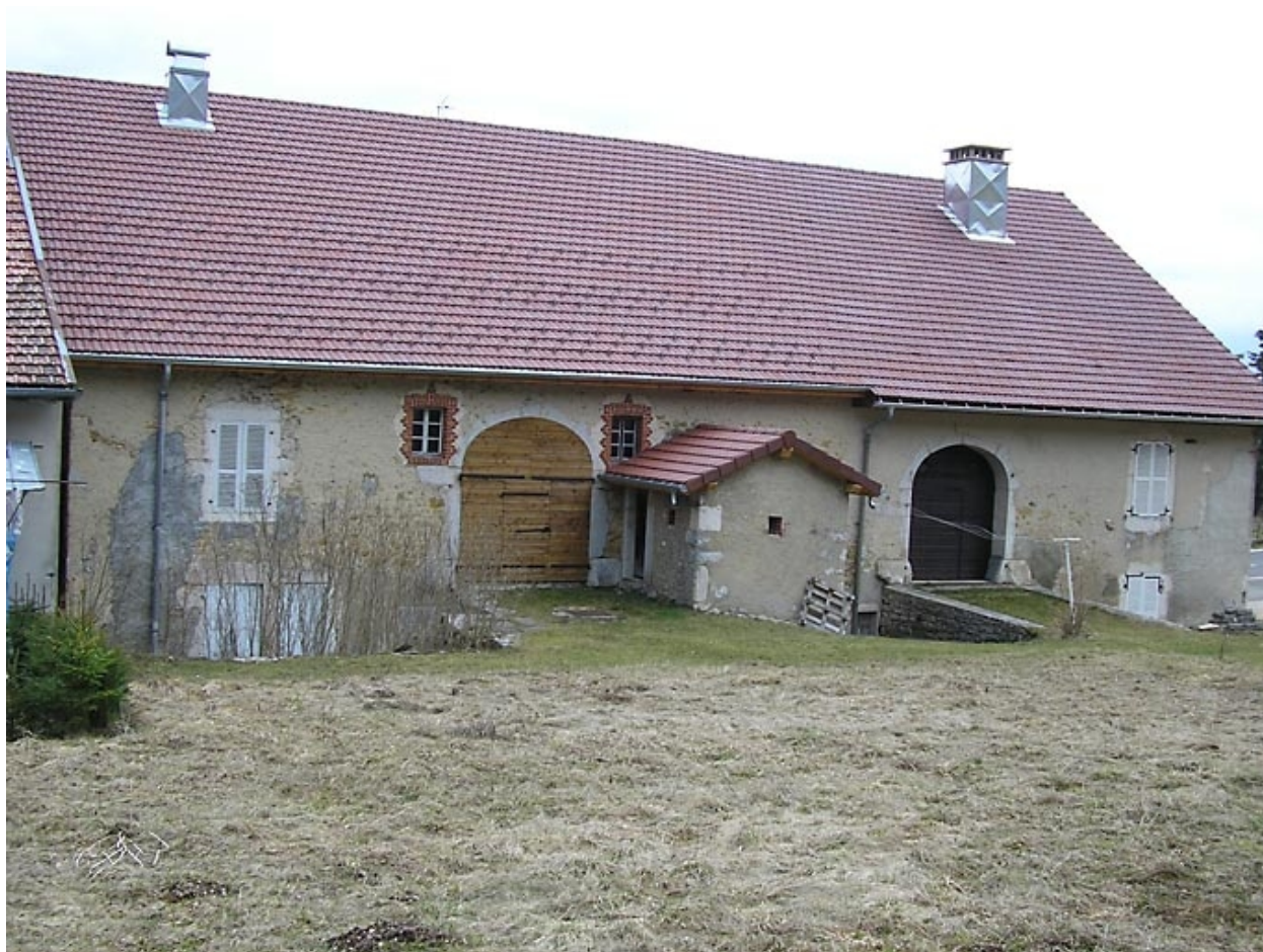
Façade postérieure et ponts de grange.
