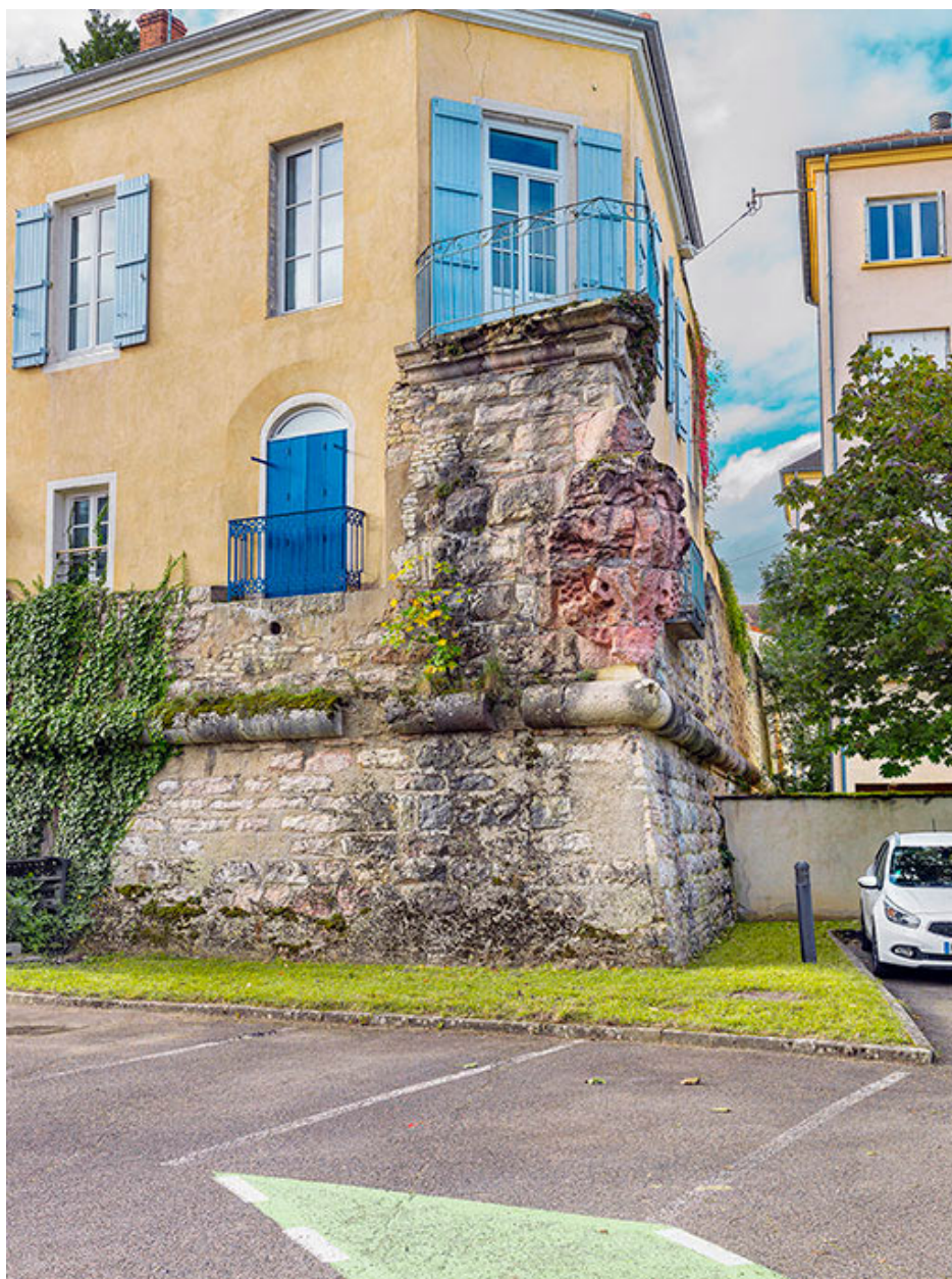
Angle du bastion Saint-Pierre.
