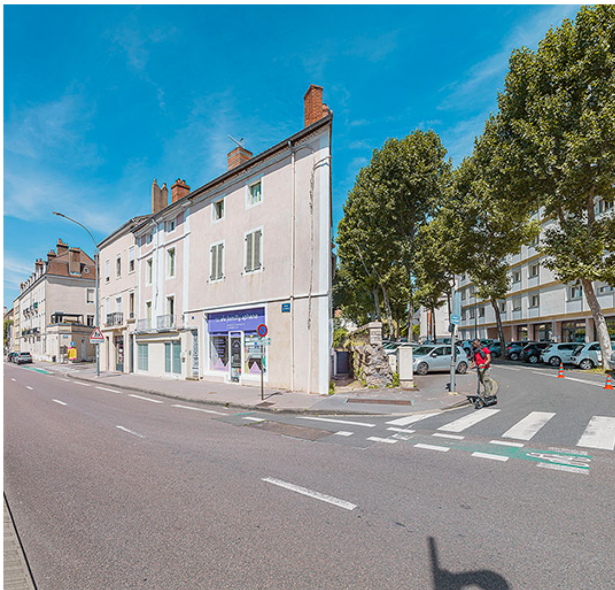
Avenue de Paris, perçant l'ancienne courtine Saint-Pierre.
