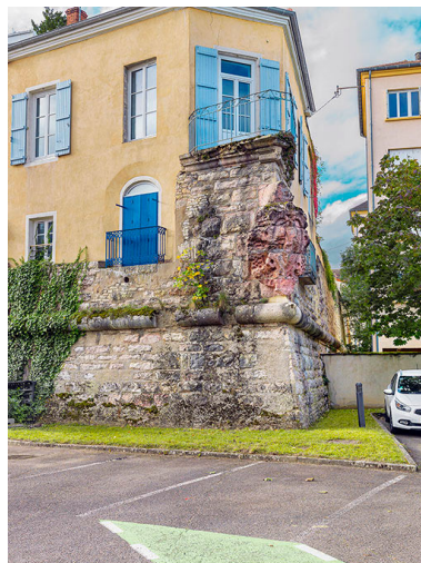
Angle du bastion Saint-Pierre.
