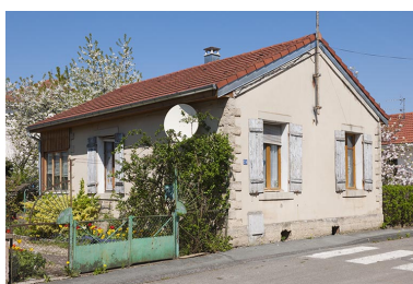
Maison individuelle (vers 1920). Phot. Jérôme Mongreville IVR43_20132500253NUC4A
