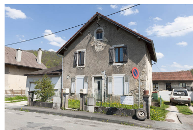
Maison individuelle (vers 1875). Phot. Jérôme Mongreville IVR43_20132500256NUC4A
