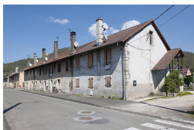
Alignement des façades des casernes (côté impair). Phot. Jérôme Mongreville IVR43_20132500259NUC4A
