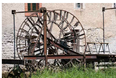
Roue hydraulique aval depuis la rive droite. Phot. Jérôme Mongreville IVR43_20152501298NUC4A
