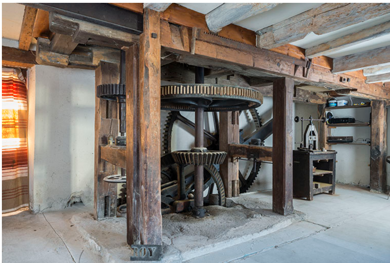
Rez-de-chaussée : beffroi (ouest) des meules.
