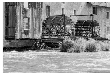
Les roues pendantes en 1980. Phot. Yves Sancey IVR43_19802500401Z
