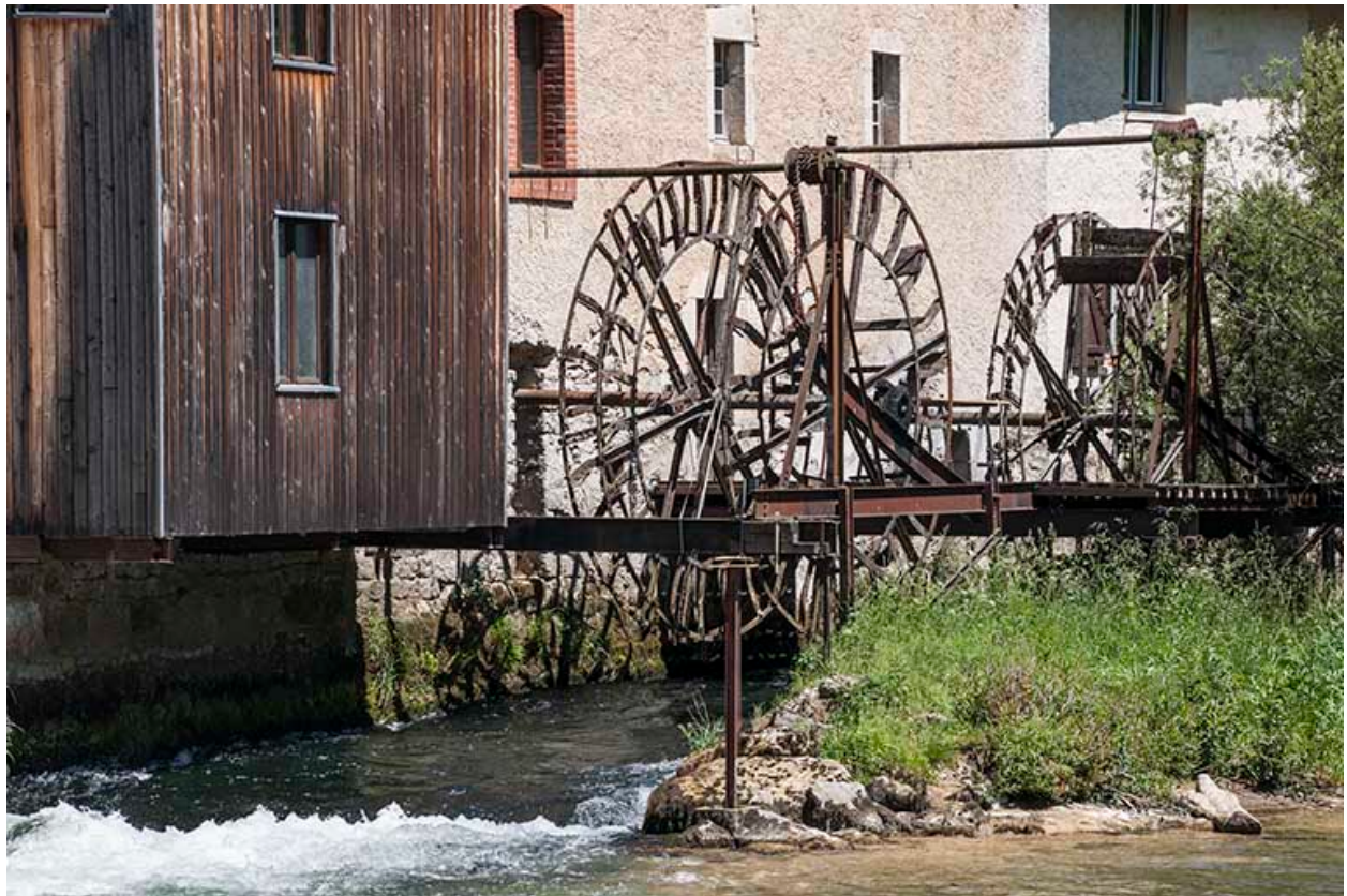
Roues hydrauliques depuis l'aval.
