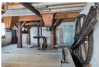
Partie sud du rez-de-chaussée : beffroi des meules et mécanisme de levage de la roue (amont). Phot. Jérôme Mongreville IVR43_20162501613NUC4A
