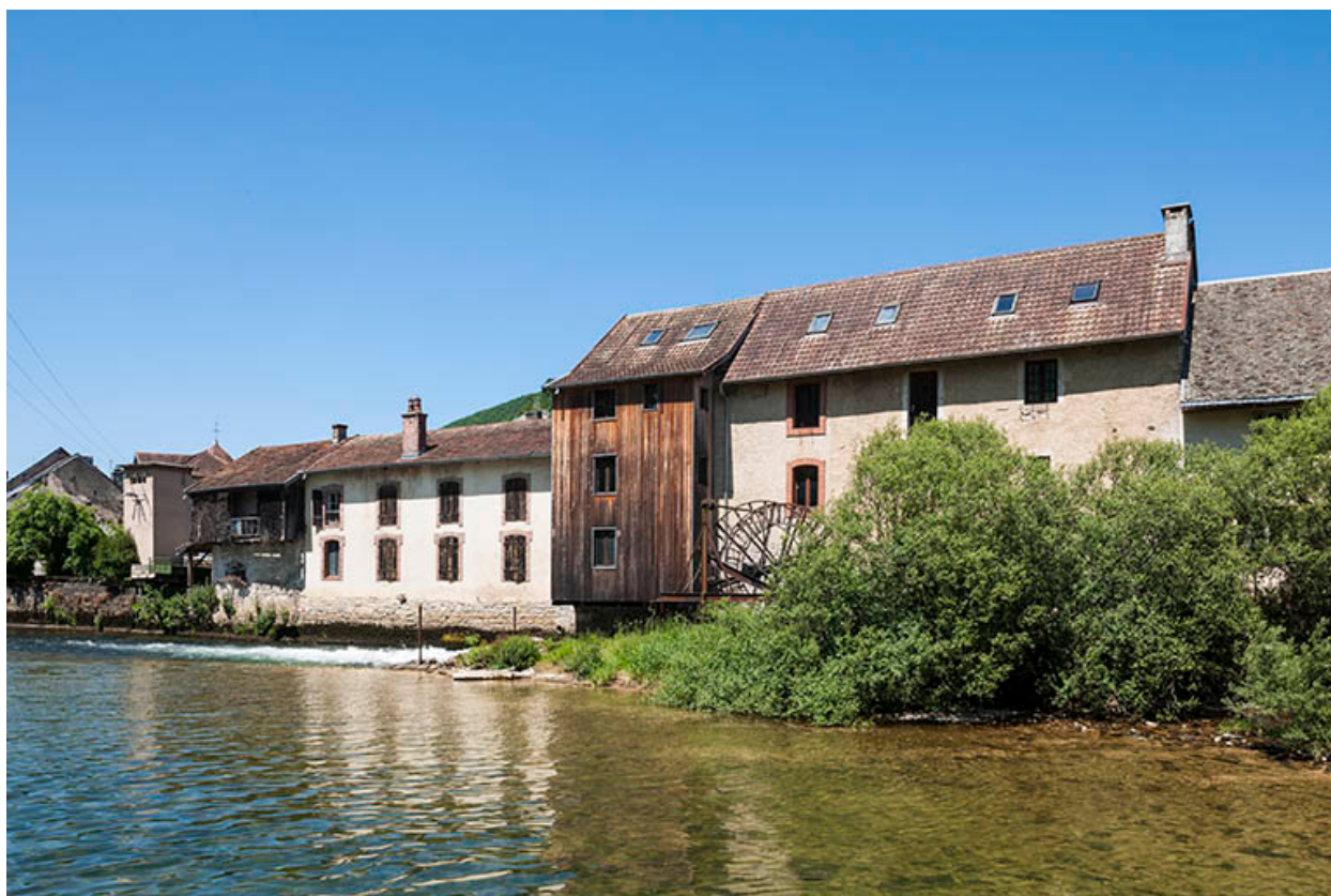
Vue d'ensemble depuis la rive droite.
