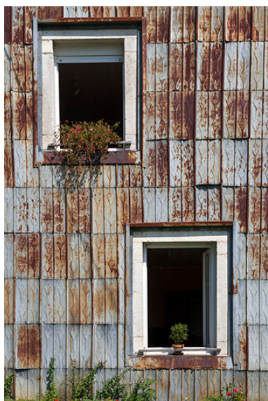
Façade latérale gauche : fenêtres et essentage de tôle.
