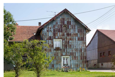
Façade latérale gauche. Phot. Yves Sancey IVR43_20132501354NUC2A
