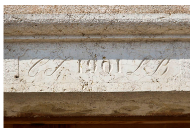
Façade antérieure : linteau daté. Phot. Yves Sancey IVR43_20132501358NUC2A
