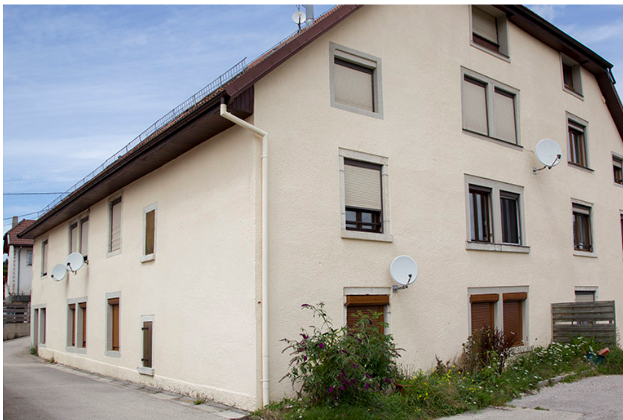
Façades postérieure et latérale droite.
