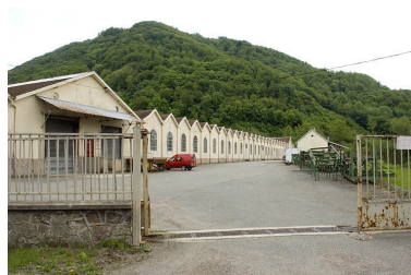
Pignons de l'atelier de fabrication depuis l'entrée. Phot. Jérôme Mongreville IVR43_20067000382NUCA
