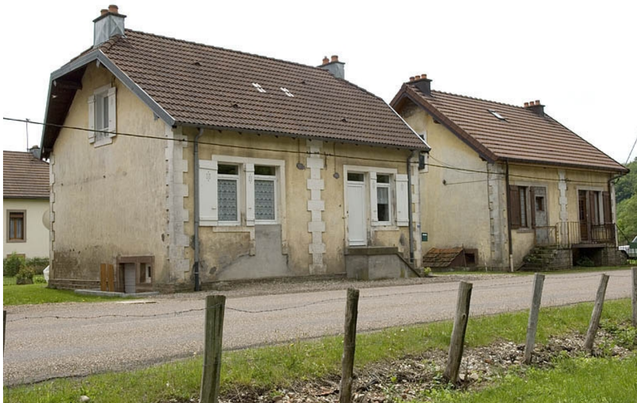
Deux logements doubles de la cité ouvrière.
