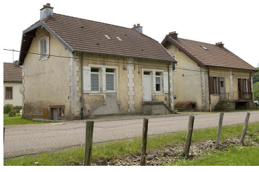
Deux logements doubles de la cité ouvrière.
