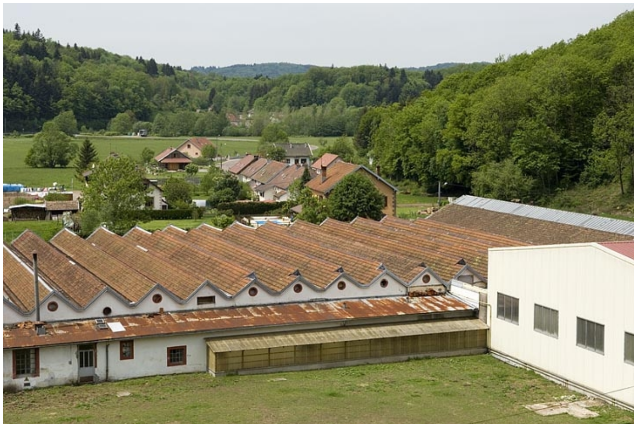
Vue plongeante depuis l'est. Extrémité nord.
