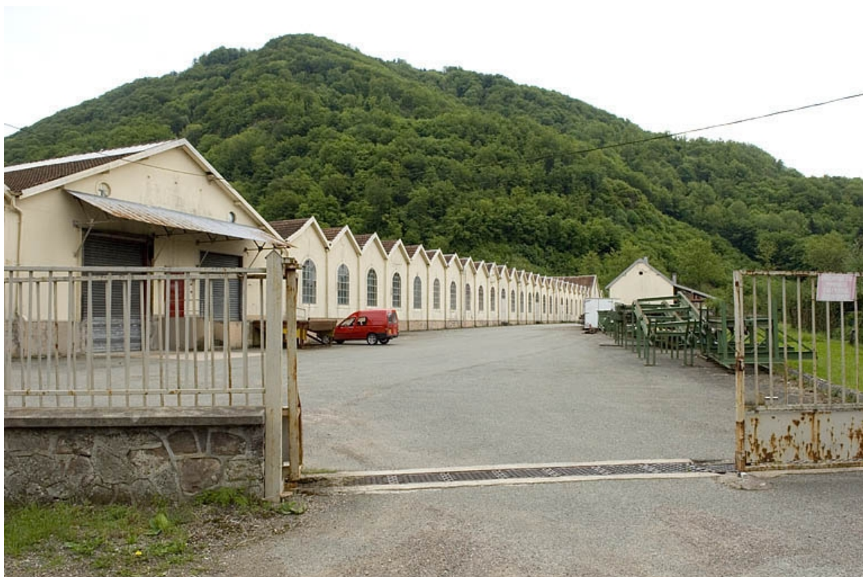
Pignons de l'atelier de fabrication depuis l'entrée.
