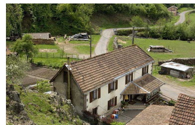
Vue plongeante sur un logement ouvrier. Phot. Jérôme Mongreville IVR43_20067000377NUCA
