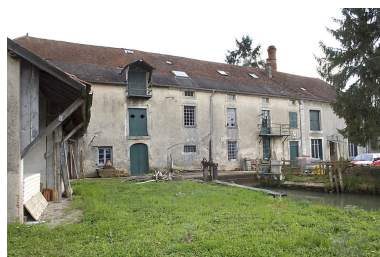
Façade antérieure depuis le nord-ouest.
