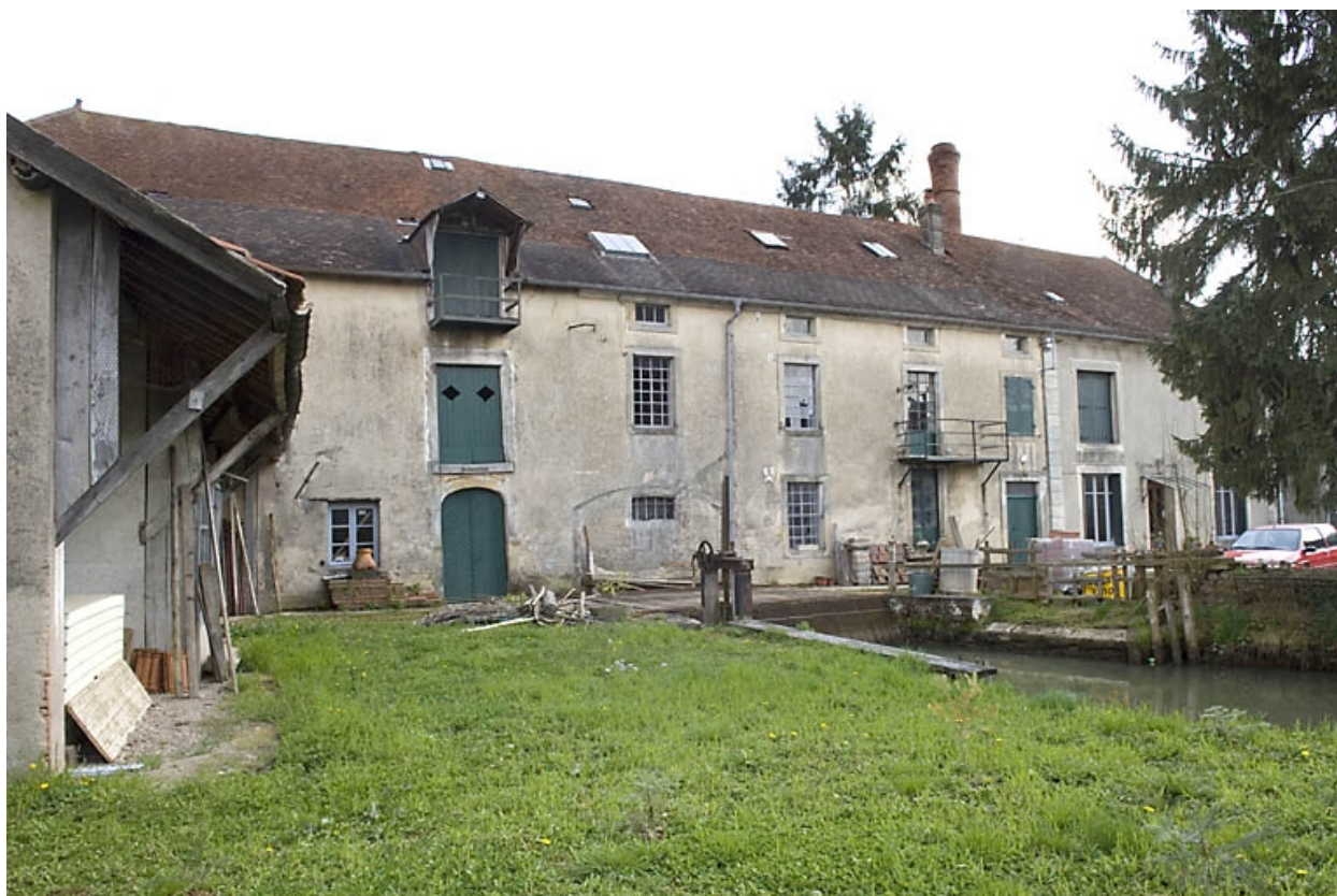
Façade antérieure depuis le nord-ouest.
