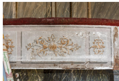
Peinture sur le garde-corps du balcon. Phot. Pierre-Marie Barbe-Richaud IVR26_20227100132NUC4A
