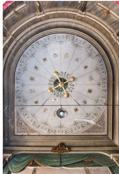
Peinture du plafond. Phot. Pierre-Marie Barbe-Richaud IVR26_20227100139NUC4A
