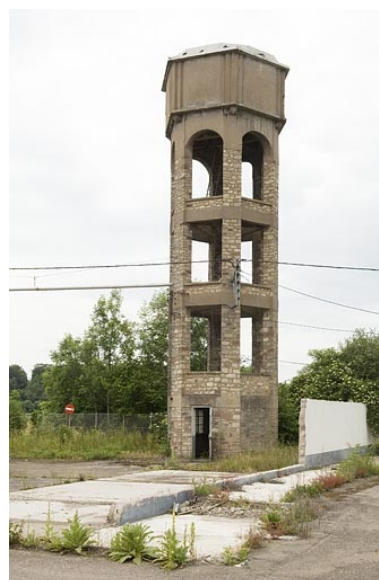
Château d'eau. Phot. Jérôme Mongreville IVR43_20097000391NUC2A
