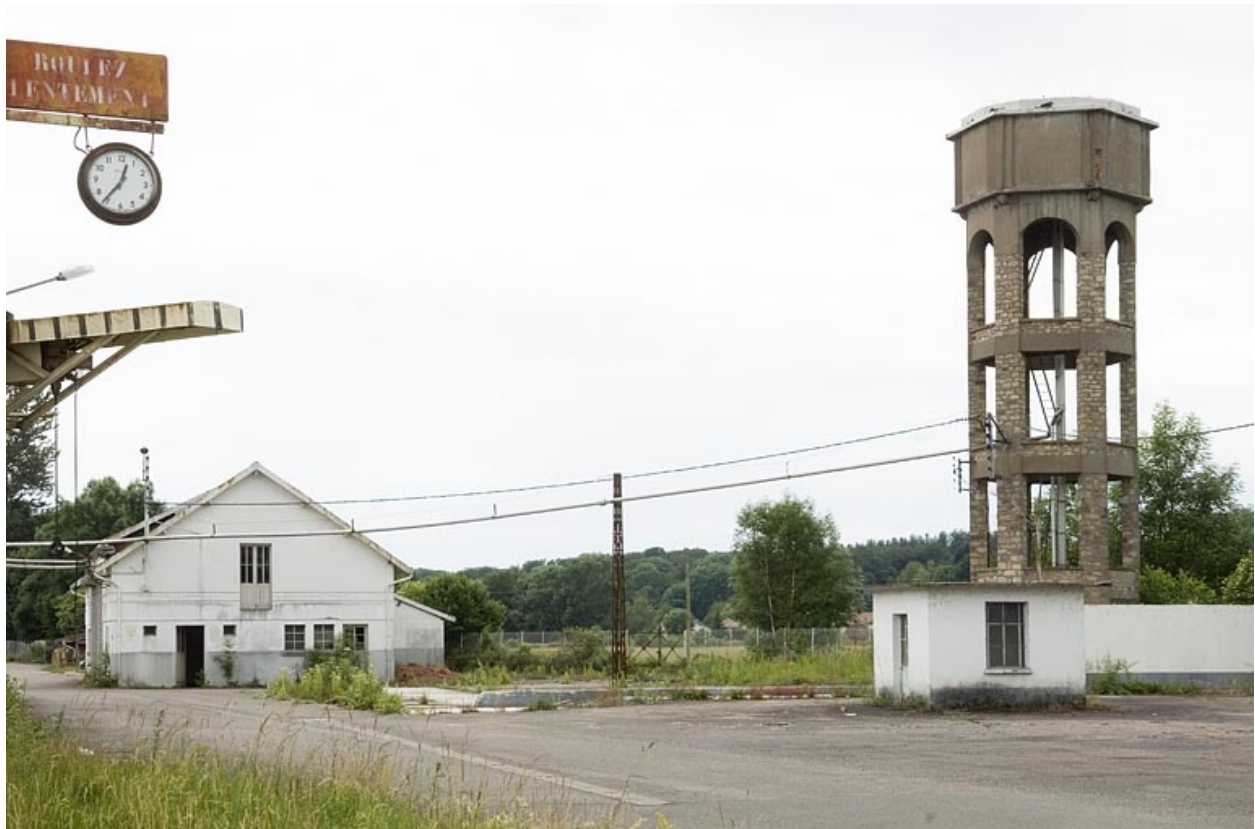
Garage à camions et château d'eau.
