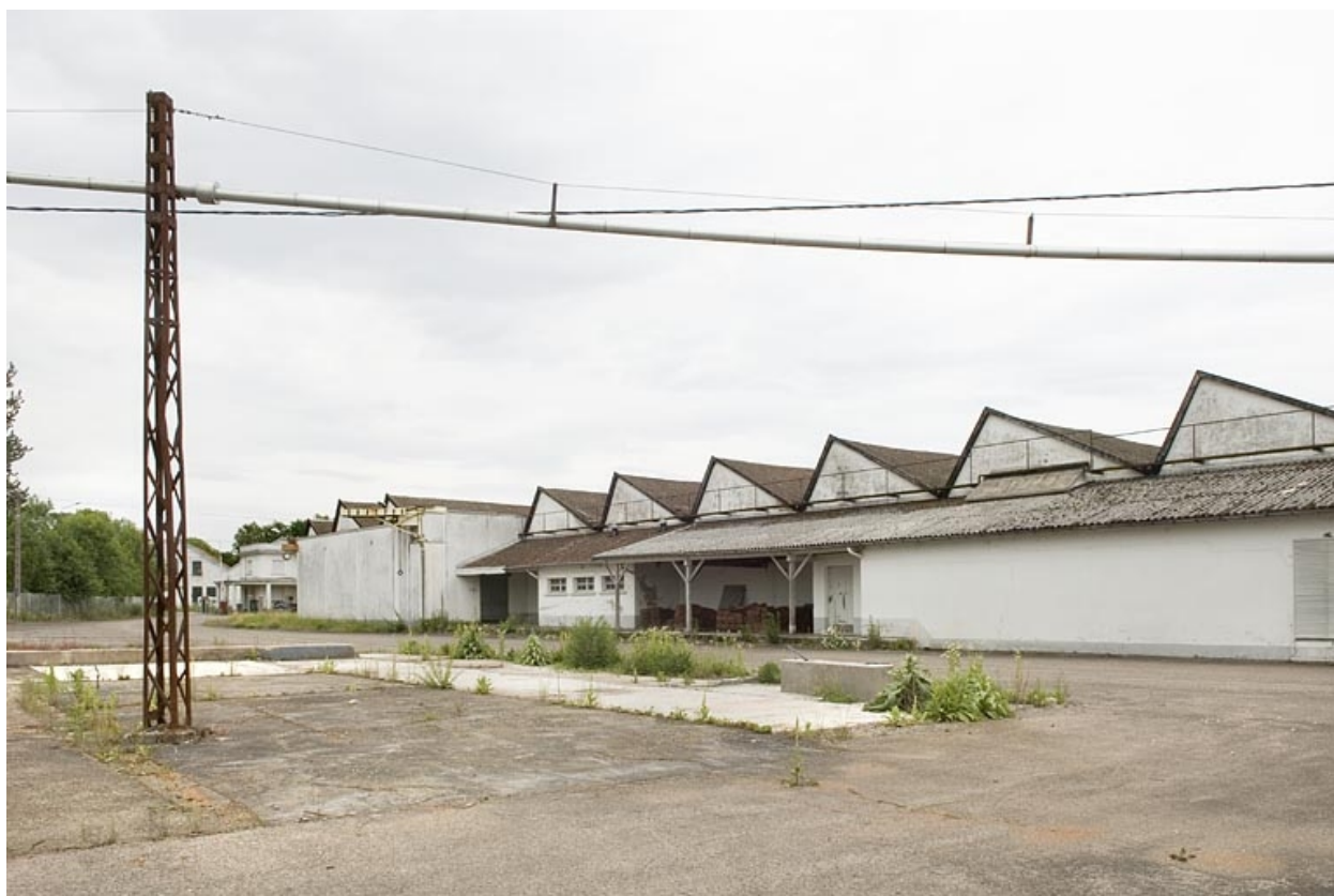
Atelier de fabrication depuis le sud-est.
