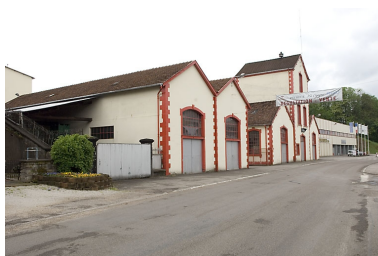
Bâtiments industriels. Vue depuis le nord-est. Phot. Jérôme Mongreville IVR43_20077000117NUCA
