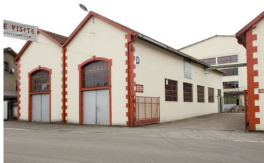
Atelier de réparation. Vue de trois quarts. Phot. Jérôme Mongreville IVR43_20077000119NUCA
