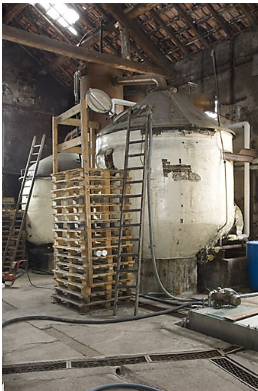
Ancien atelier de distillation. Alambics de 100 hl.
