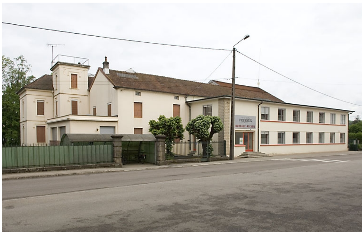
Ancien logement patronal et bureau.
