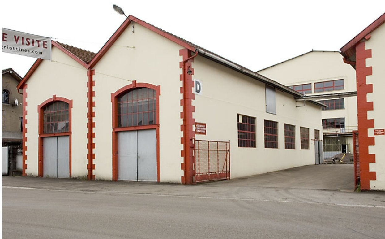
Atelier de réparation. Vue de trois quarts.
