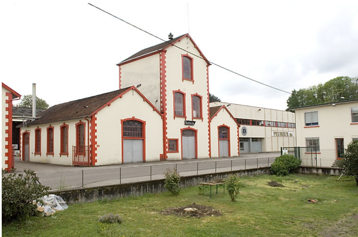
Bâtiments industriels. Vue de trois quarts gauche.
