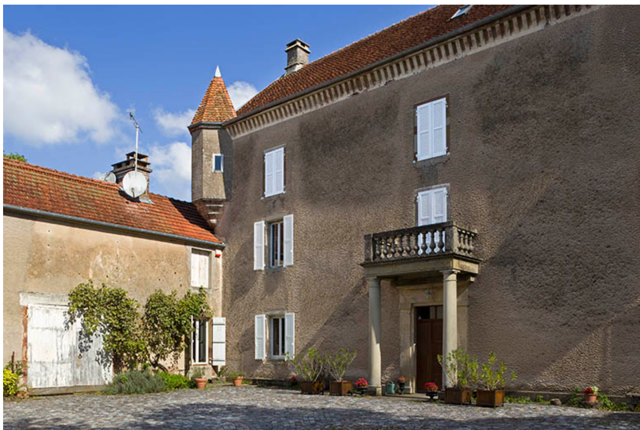
La cour, façade postérieure.
