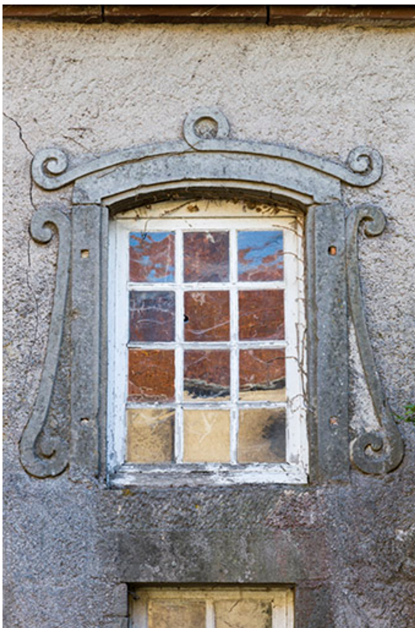
Détail d'une baie, façade ouest.
