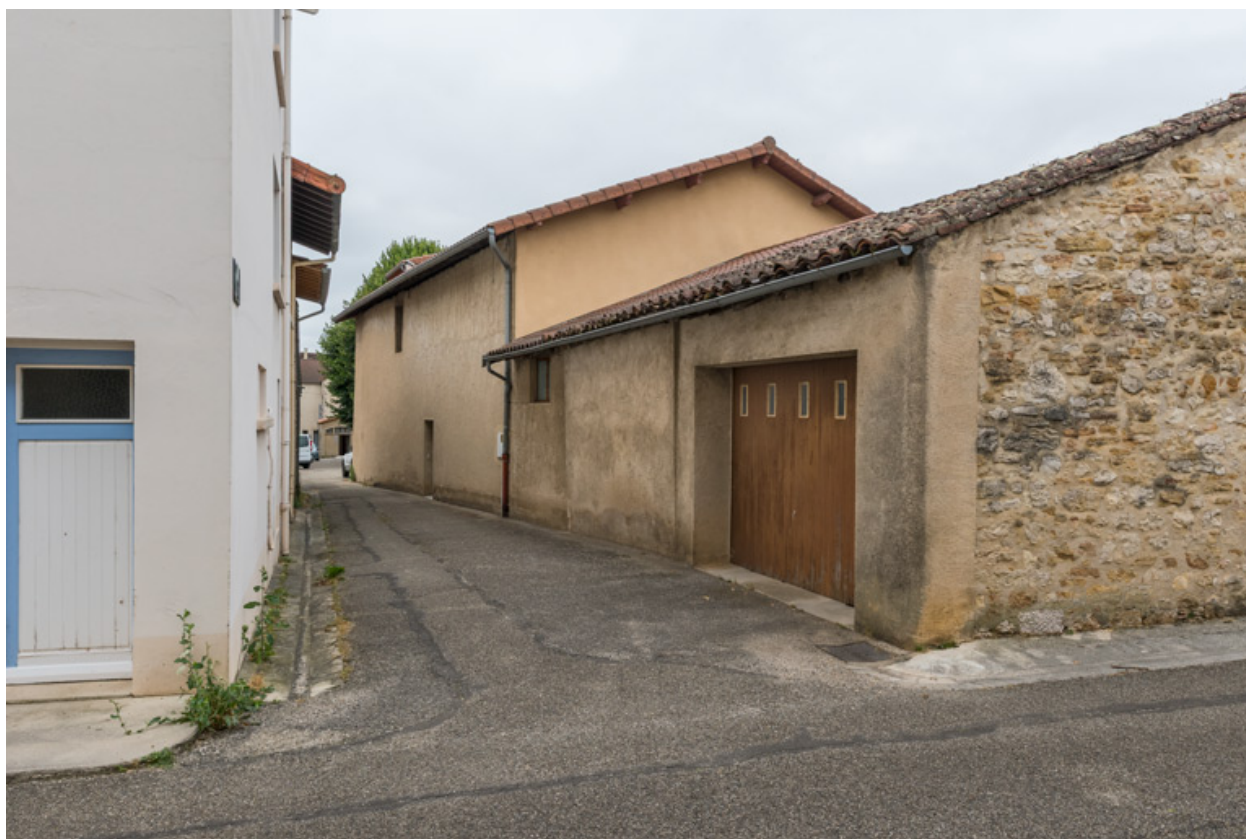
Façades postérieure et latérale droite.
