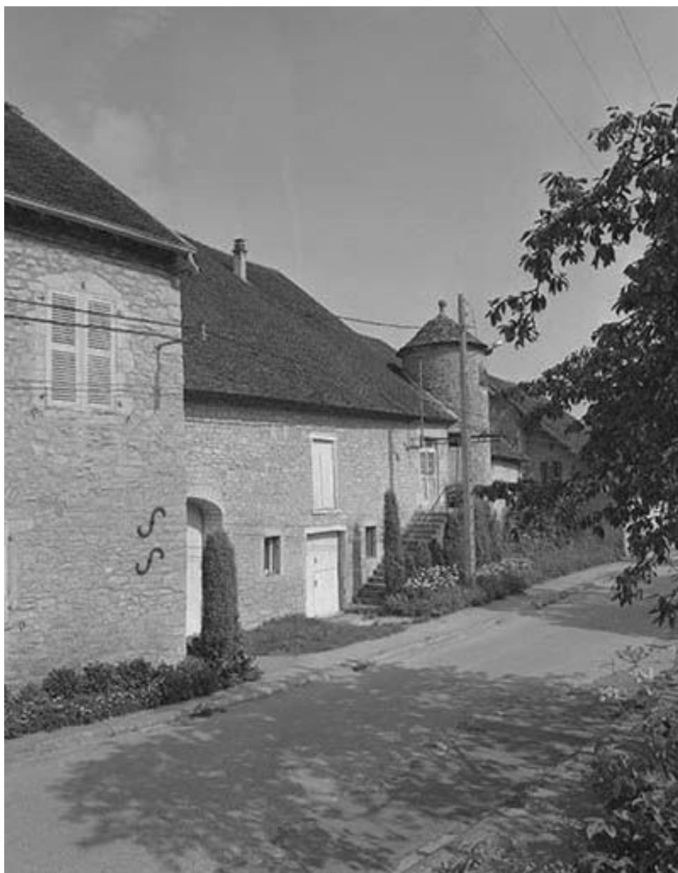
Façade sur rue, partie gauche.
