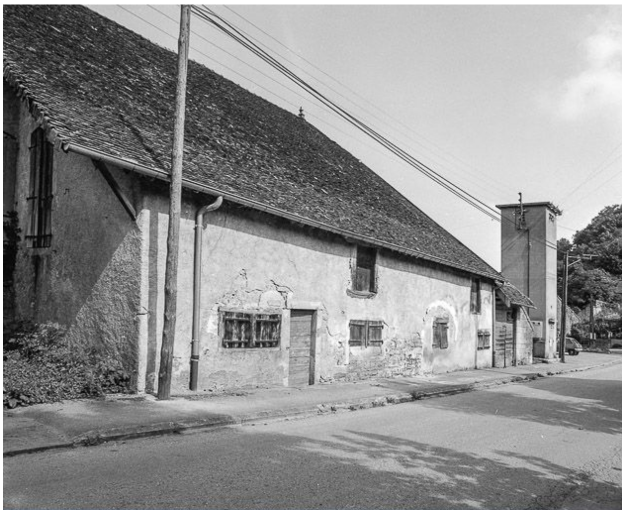
Façade sur rue, partie droite.
