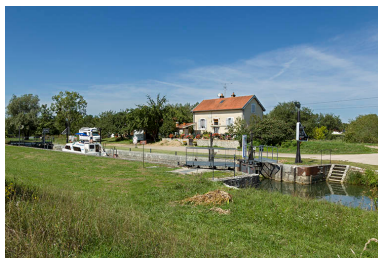
Vue générale du site d'écluse. Phot. Sonia Dourlot IVR43_20157000862NUC2A
