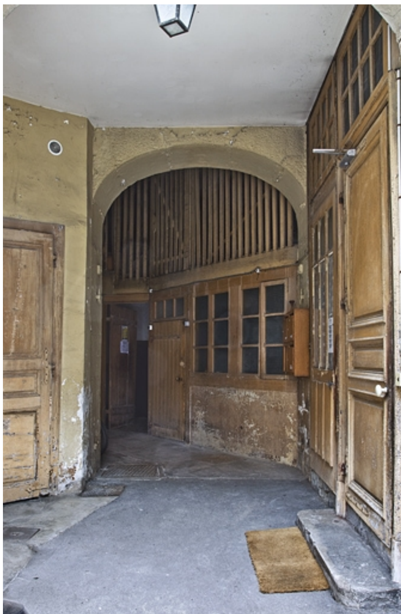
Vue d'ensemble de l'entrée de l'écurie.
