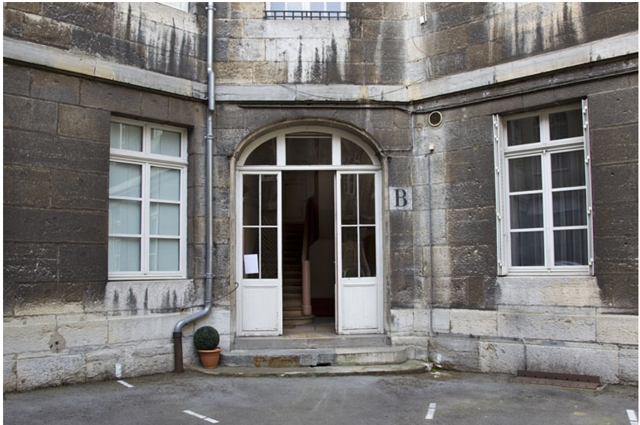
Logis principal : entrée secondaire de l'aile droite.
