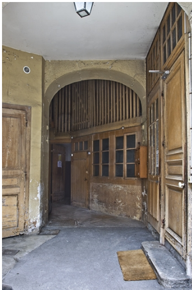
Vue d'ensemble de l'entrée de l'écurie.
