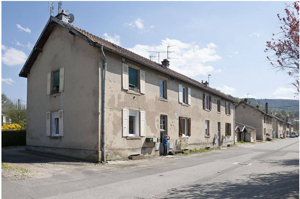
Façades ouest des habitations (côté impair).
