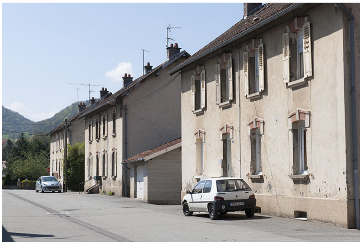
Façades antérieures d'habitations (3-4 logements).
