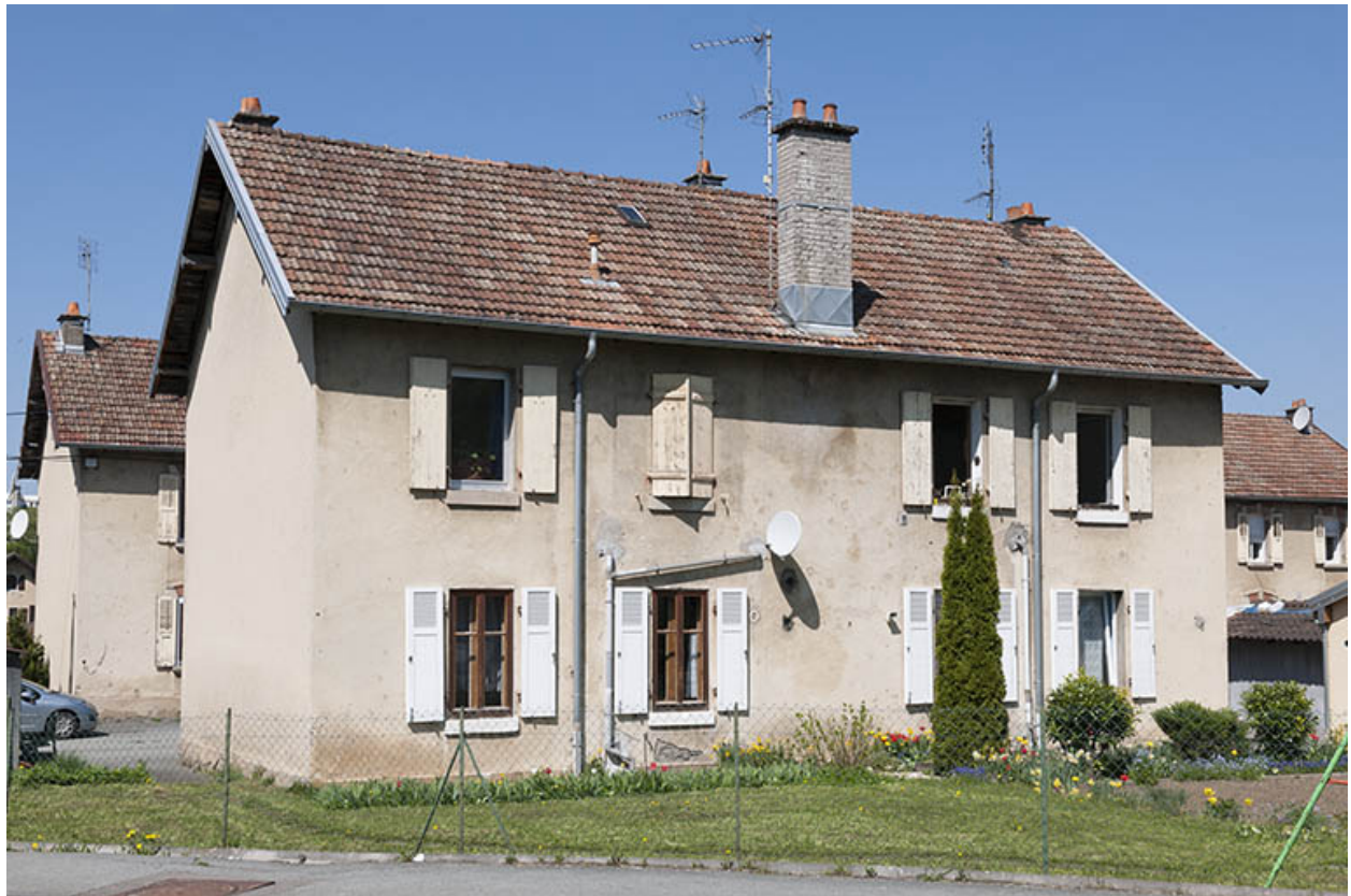
Façade postérieure d'une habitation.
