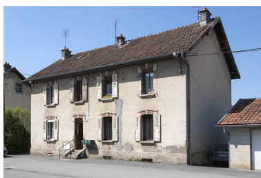
Habitation vue de trois quarts droite. Phot. Jérôme Mongreville IVR43_20132500244NUC4A
