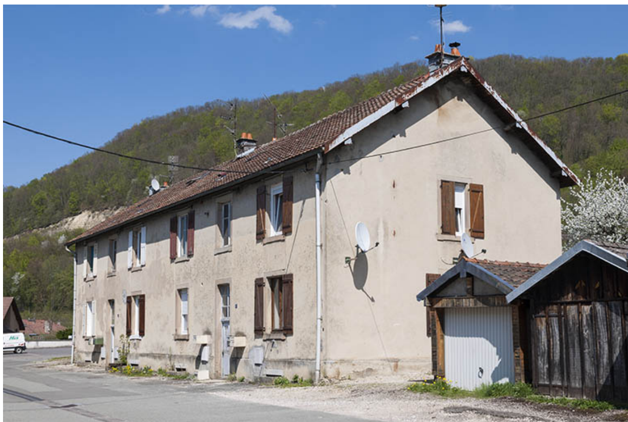
Habitation (6-8 logements) vue de trois quarts.
