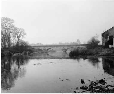
Vue d'ensemble. Phot. non renseigné IVR26_19728901256X
