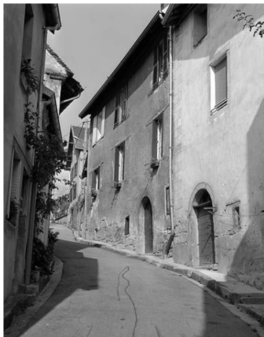
Elévation rue de Reine. Phot. Yves Sancey IVR43_19802500988X
