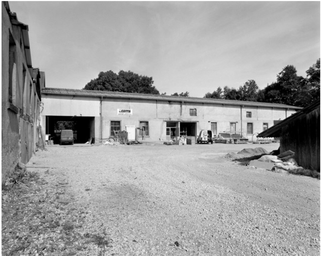
Atelier de fabrication ouest.
