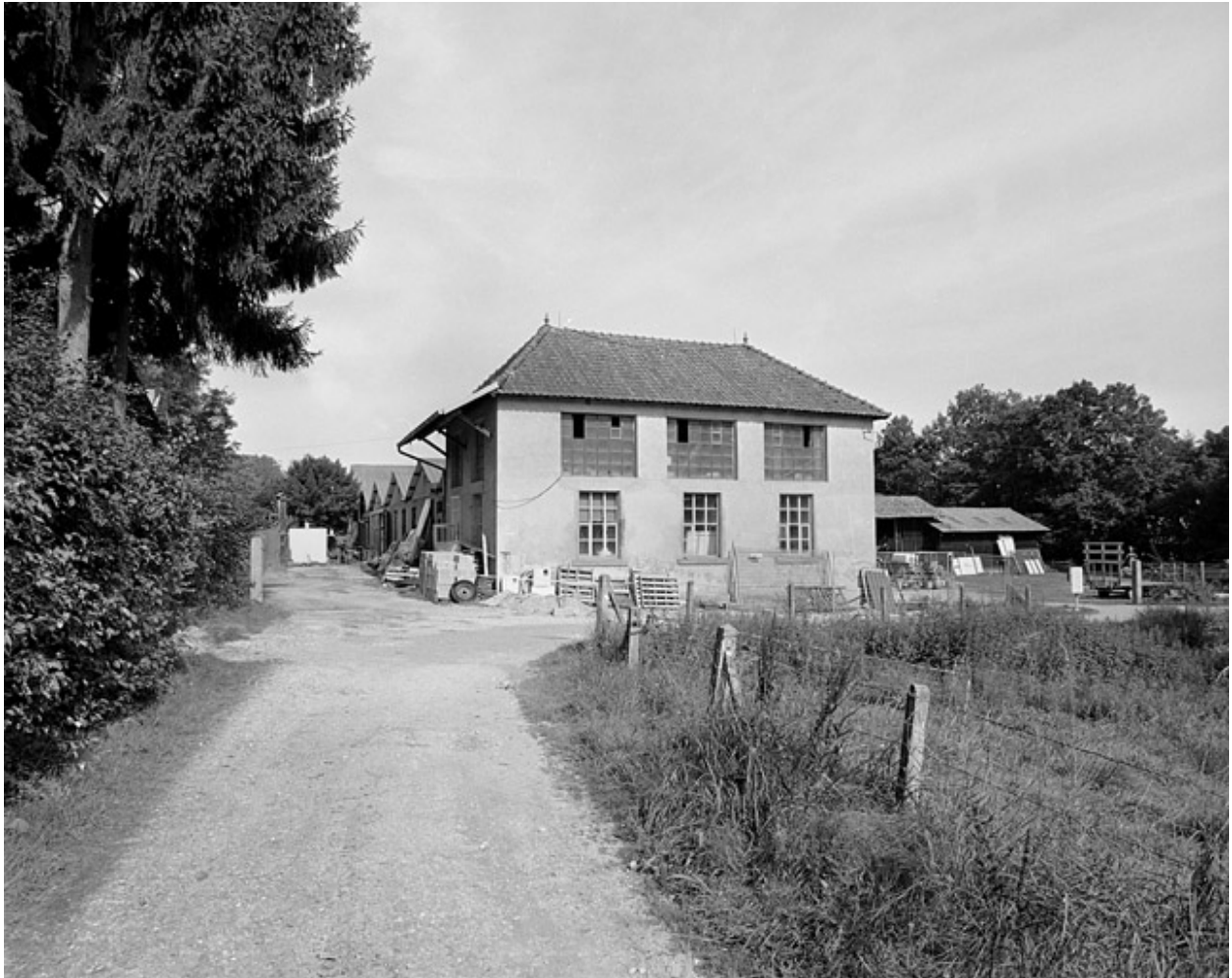
Atelier de réparation et bureau.
