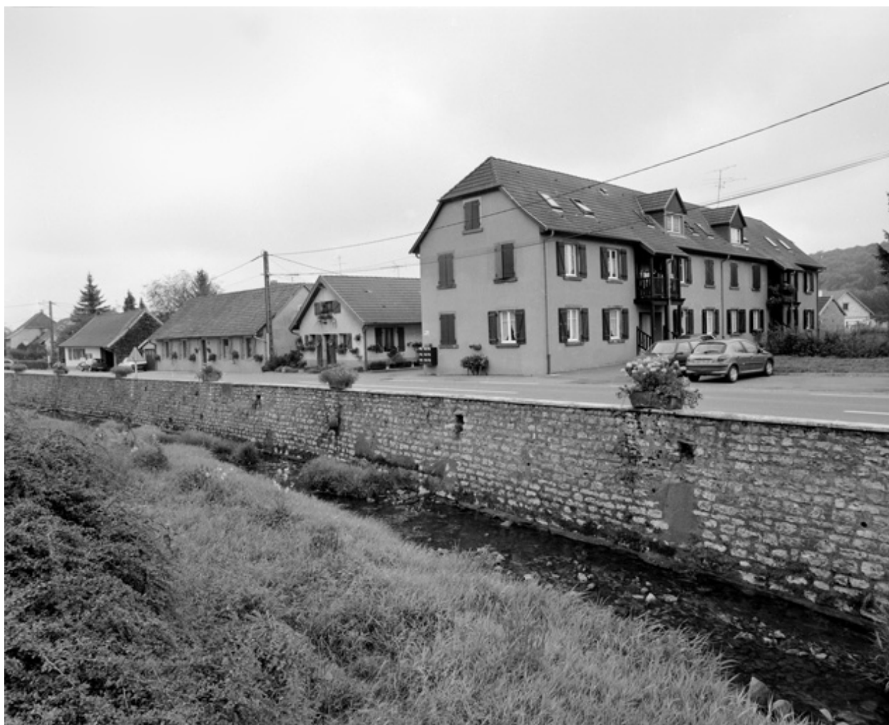
Vue d'ensemble des logements ouvriers.
