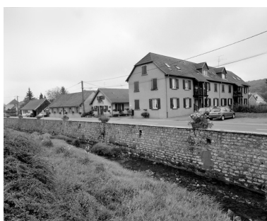
Vue d'ensemble des logements ouvriers. Phot. Yves Sancey IVR43_19999000133X
