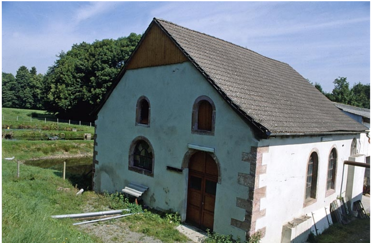
Salle des machines.
