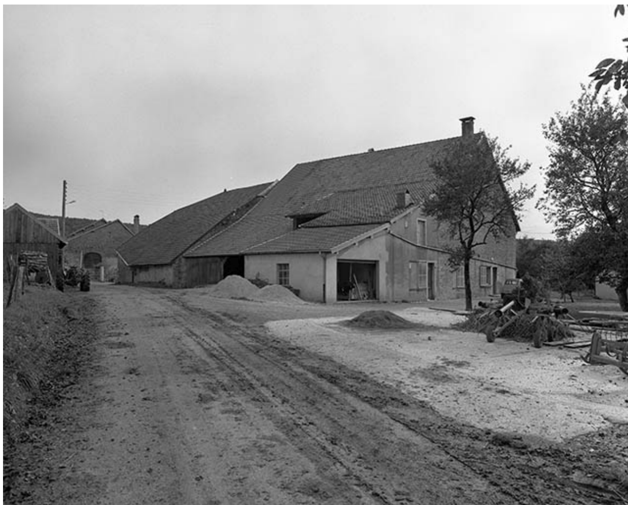
Ferme située 5 rue de Naglans.
