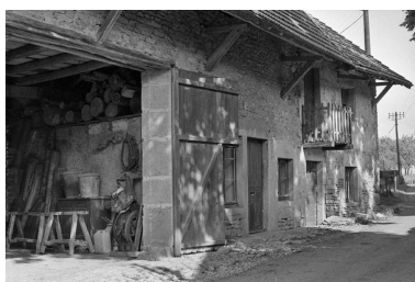
Ferme située 11 rue de Tarcenay (en ruine en 2019). Phot. Gilbert Poinot
