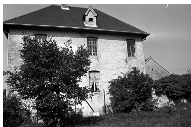
Presbytère. Phot. Gilbert Poinot IVR43_19762500908Z
