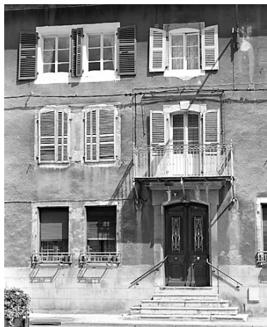
Façade antérieure : travées centrales. Phot. Yves Sancey IVR43_20033900077X
