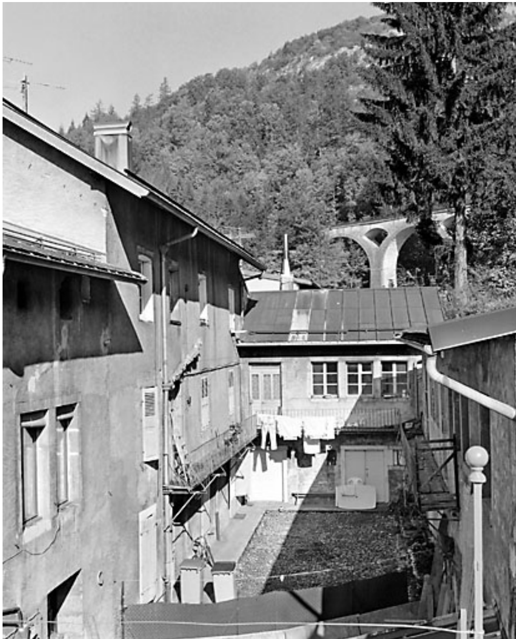
Façade postérieure, vue en enfilade.
