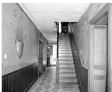
Couloir et escalier droit. Phot. Yves Sancey IVR43_20033900064X
