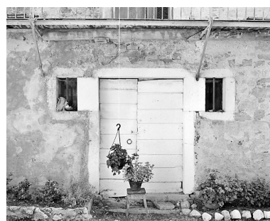
Baies d'un bûcher. Phot. Yves Sancey IVR43_20033900063X
