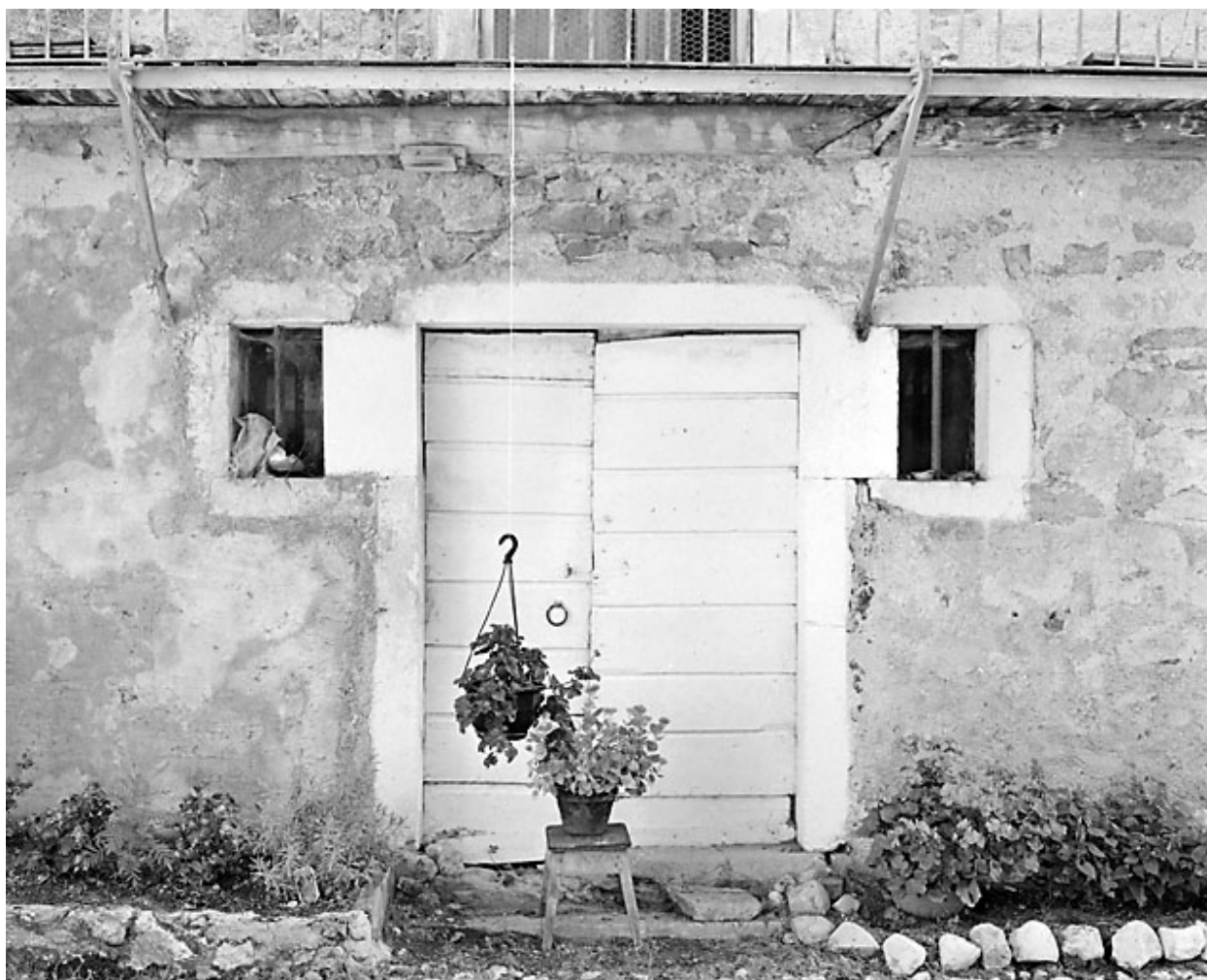
Baies d'un bûcher.
