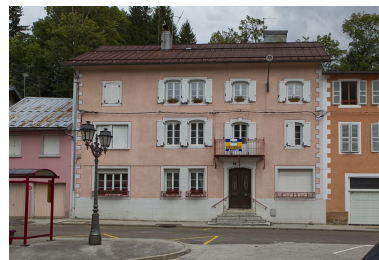
Façade antérieure. Phot. Yves Sancey IVR43_20103900481NUC2A
