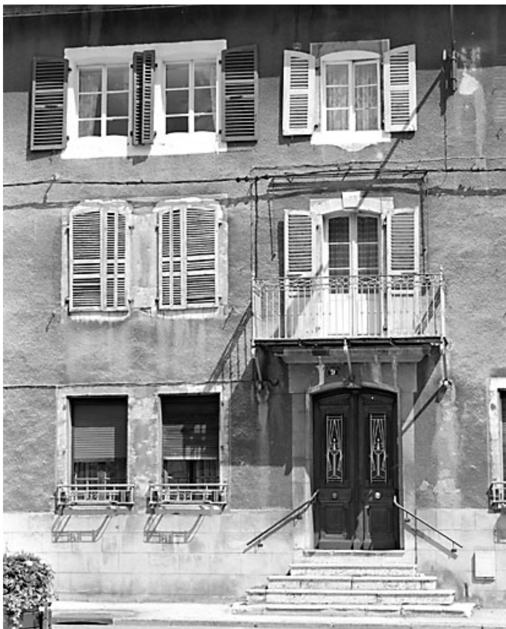
Façade antérieure : travées centrales.
