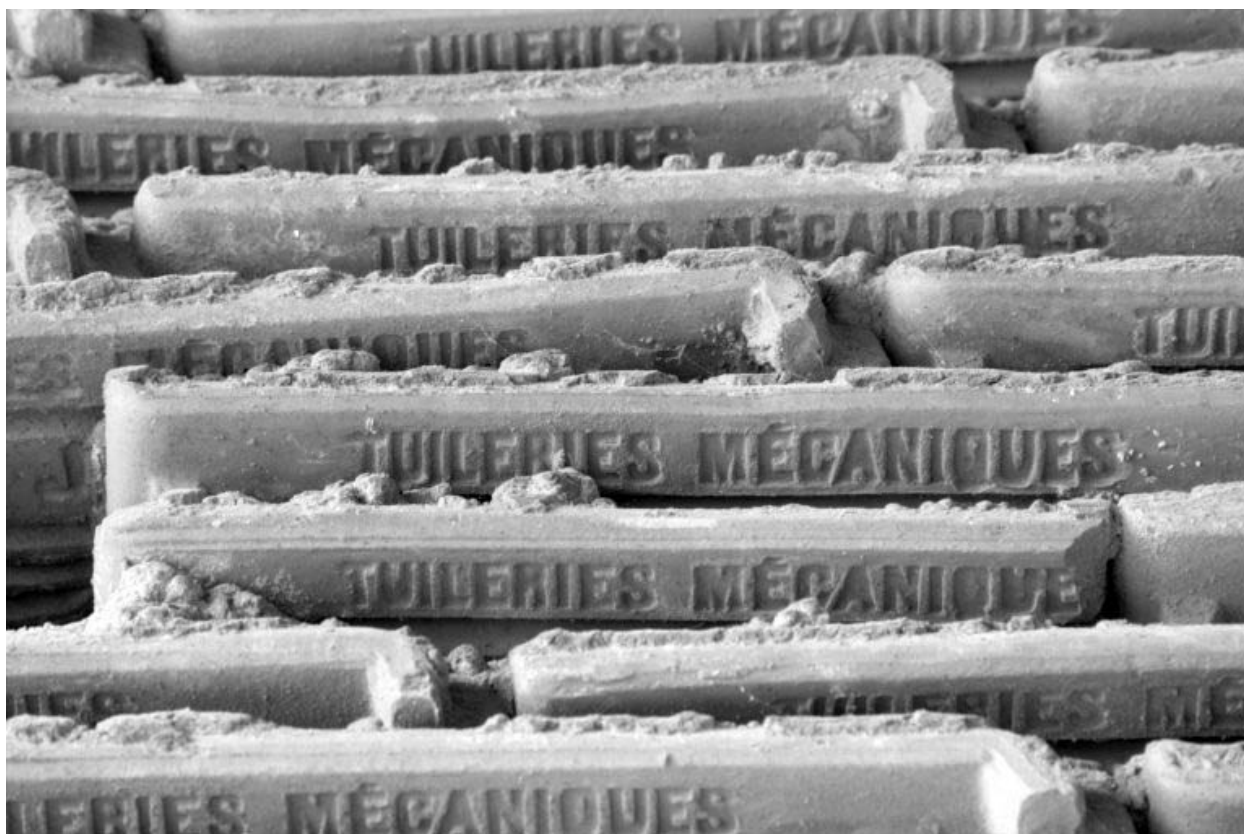
Détail de l'appareil de tuiles en gros-oeuvre.
