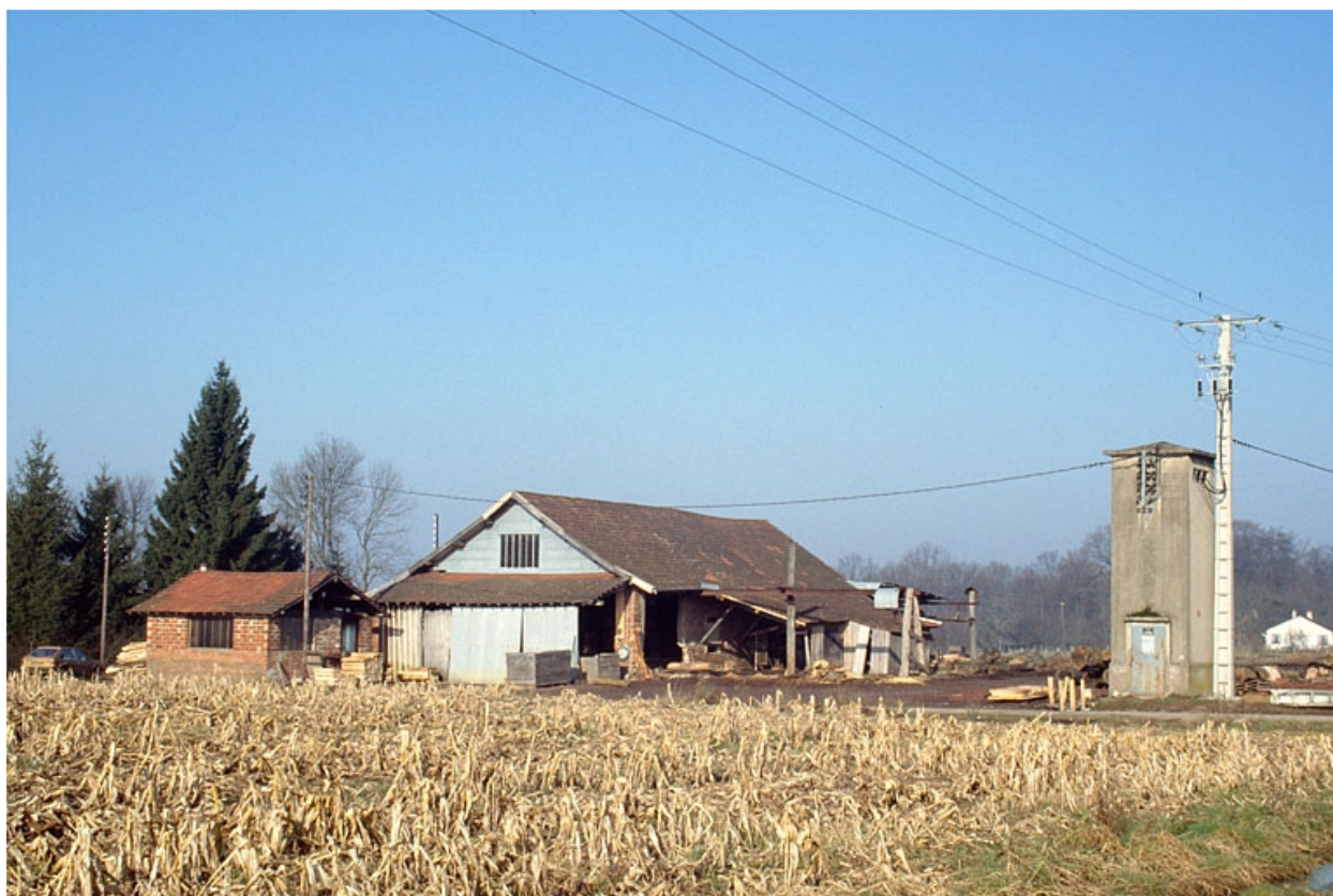
Vue d'ensemble depuis le sud.
