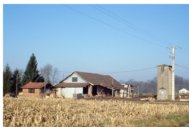
Vue d'ensemble depuis le sud. Phot. Laurent Poupard IVR43_19893900005ZA
