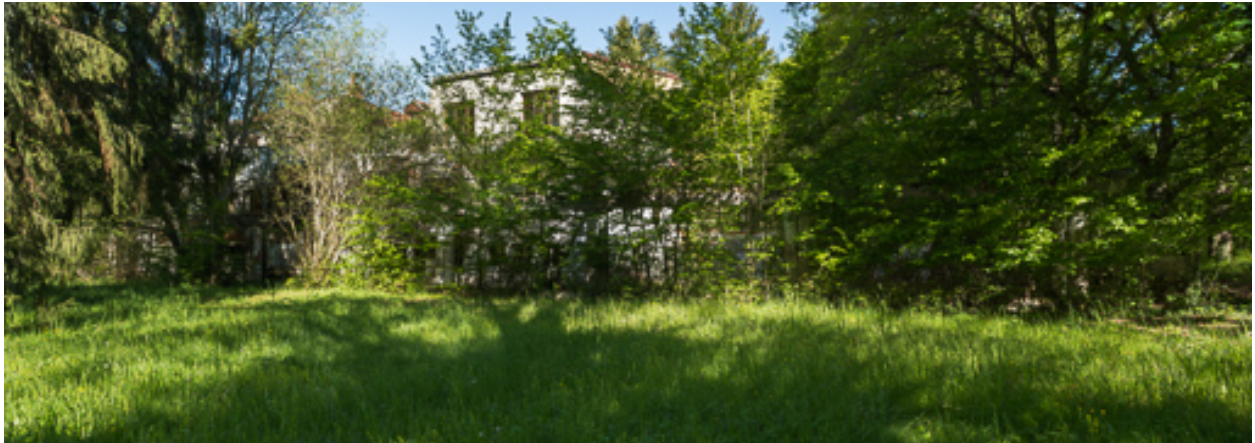
Vue de trois quarts depuis l'est.
