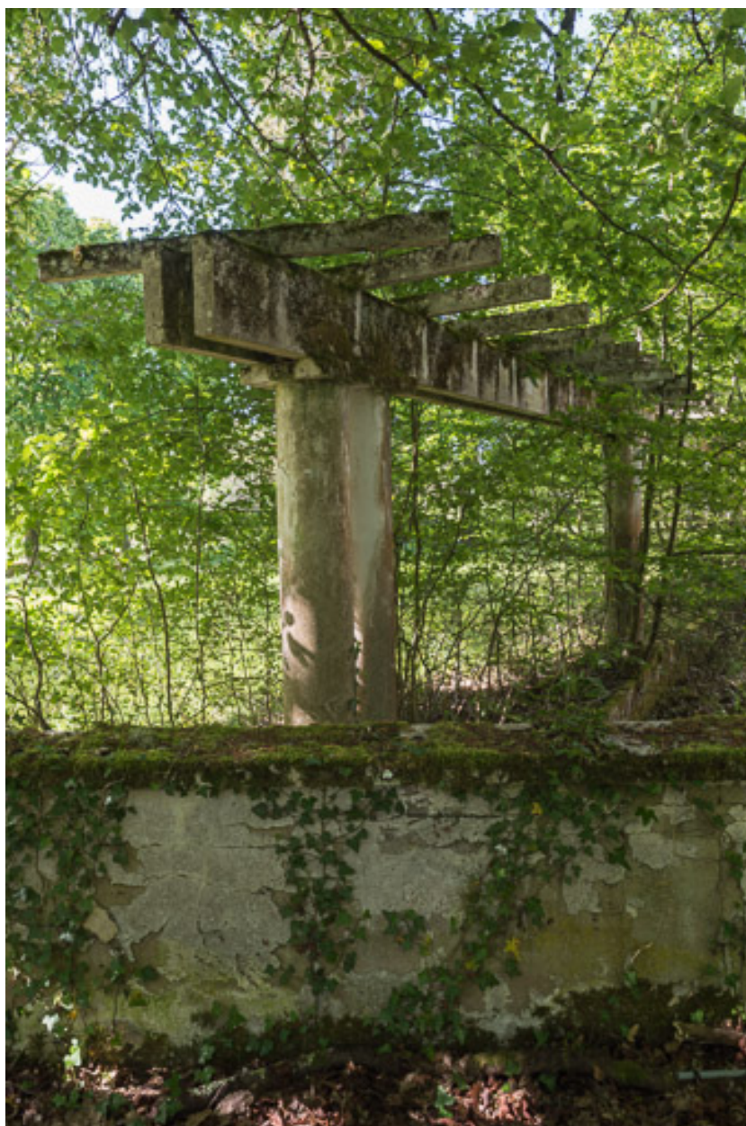
Pergola, vue depuis le nord-est, détail.
