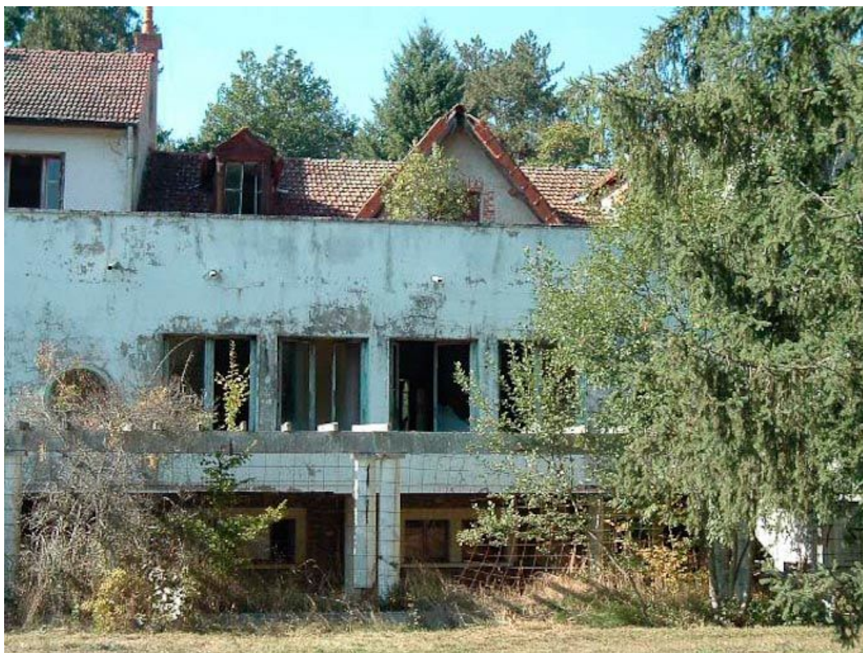
Bâtiment principal, façade antérieure, partie droite.
