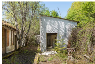
Bâtiment des bains, vue extérieure. Phot. Pierre-Marie Barbe-Richaud IVR26_20192100061NUC4A
