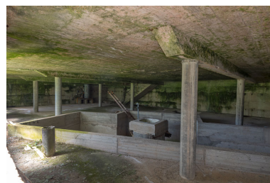
Aménagement du captage de la source, vue intérieure. Phot. Pierre-Marie Barbe-Richaud IVR26_20192100070NUC4A
