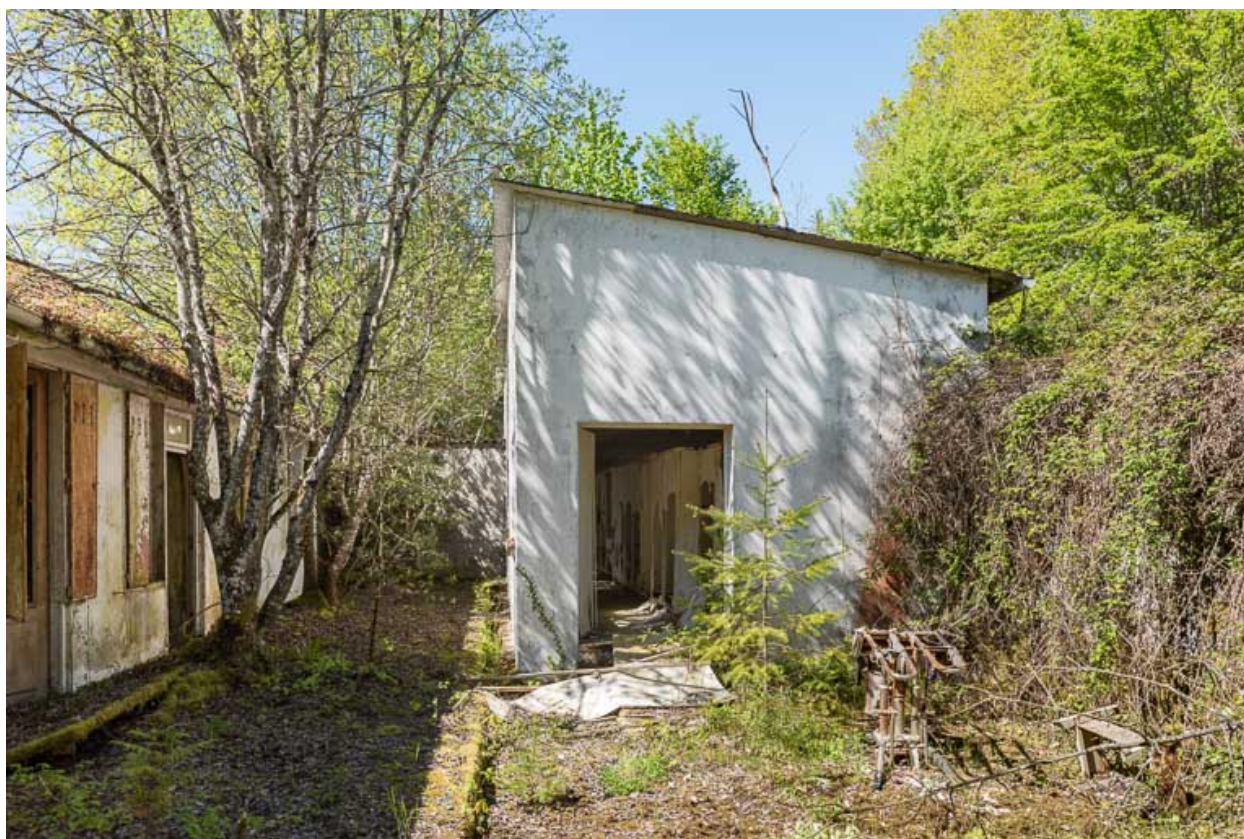
Bâtiment des bains, vue extérieure.
