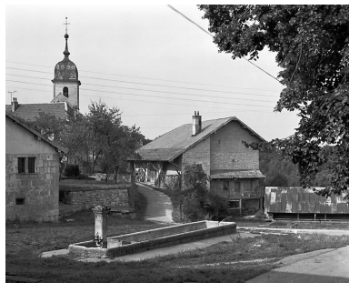
Vue générale. Phot. Yves Sancey IVR43_19802500879X
