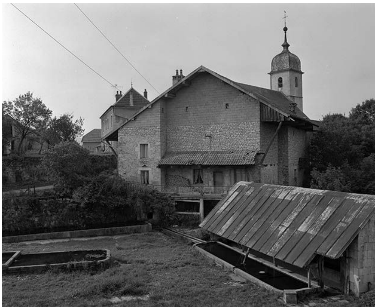
Elévation du logis.
