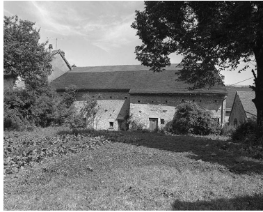
Façade postérieure. Phot. Yves Sancey IVR43_19803900248X
