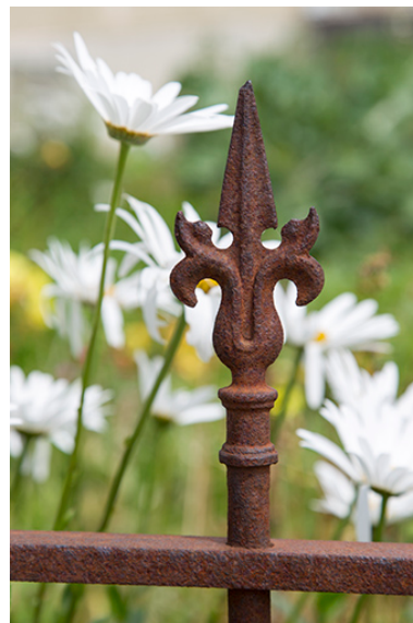
Détail de la grille du jardin. Phot. Sonia Dourlot IVR43_20142501796NUC2A
