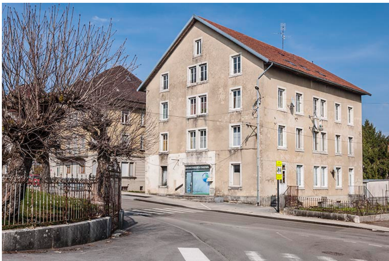
Façades antérieure et latérale droite.
