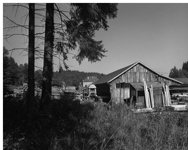
Atelier de fabrication (sciage) depuis le sud. Phot. Yves Sancey IVR43_19973901223X
