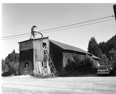
La parqueterie (désaffectée).
