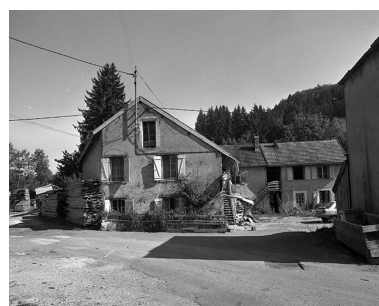
Logements d'ouvriers depuis l'ouest.
