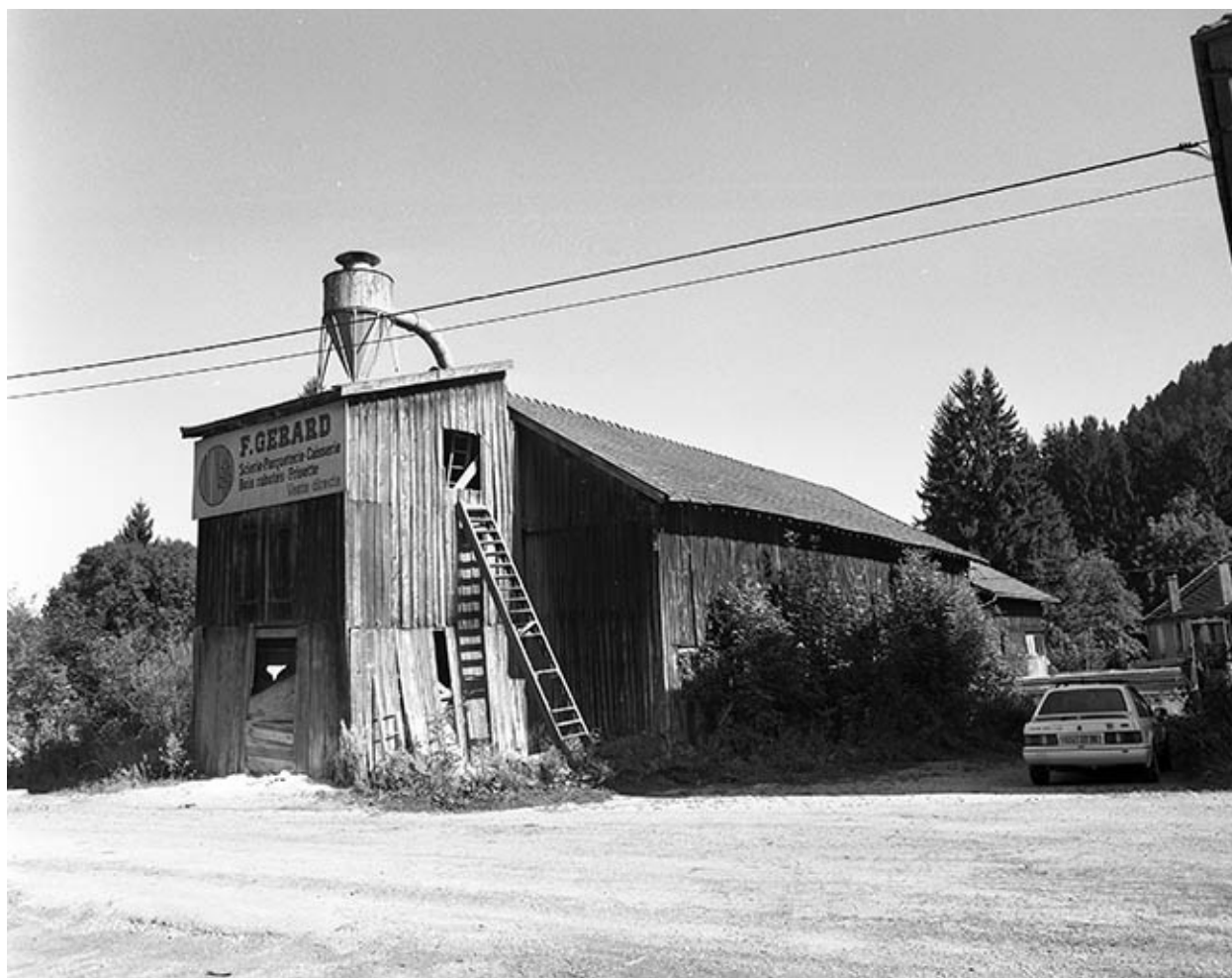
La parqueterie (désaffectée).
