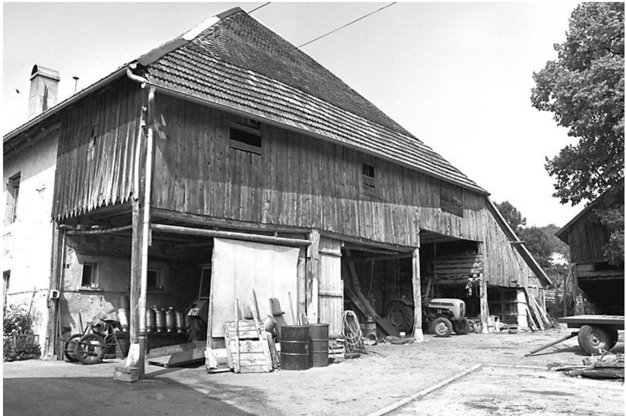
Façade latérale droite.
