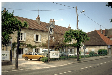
Bureau-logement patronal et magasin industriel (C). Phot. Laurent Poupard IVR43_19893900179ZA
