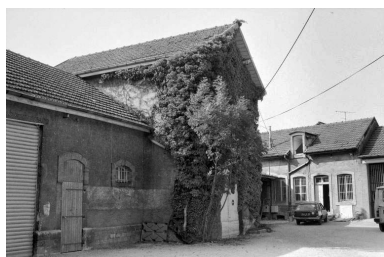
Magasins industriels (A, G-H). Phot. Laurent Poupard IVR43_19893900181Z
