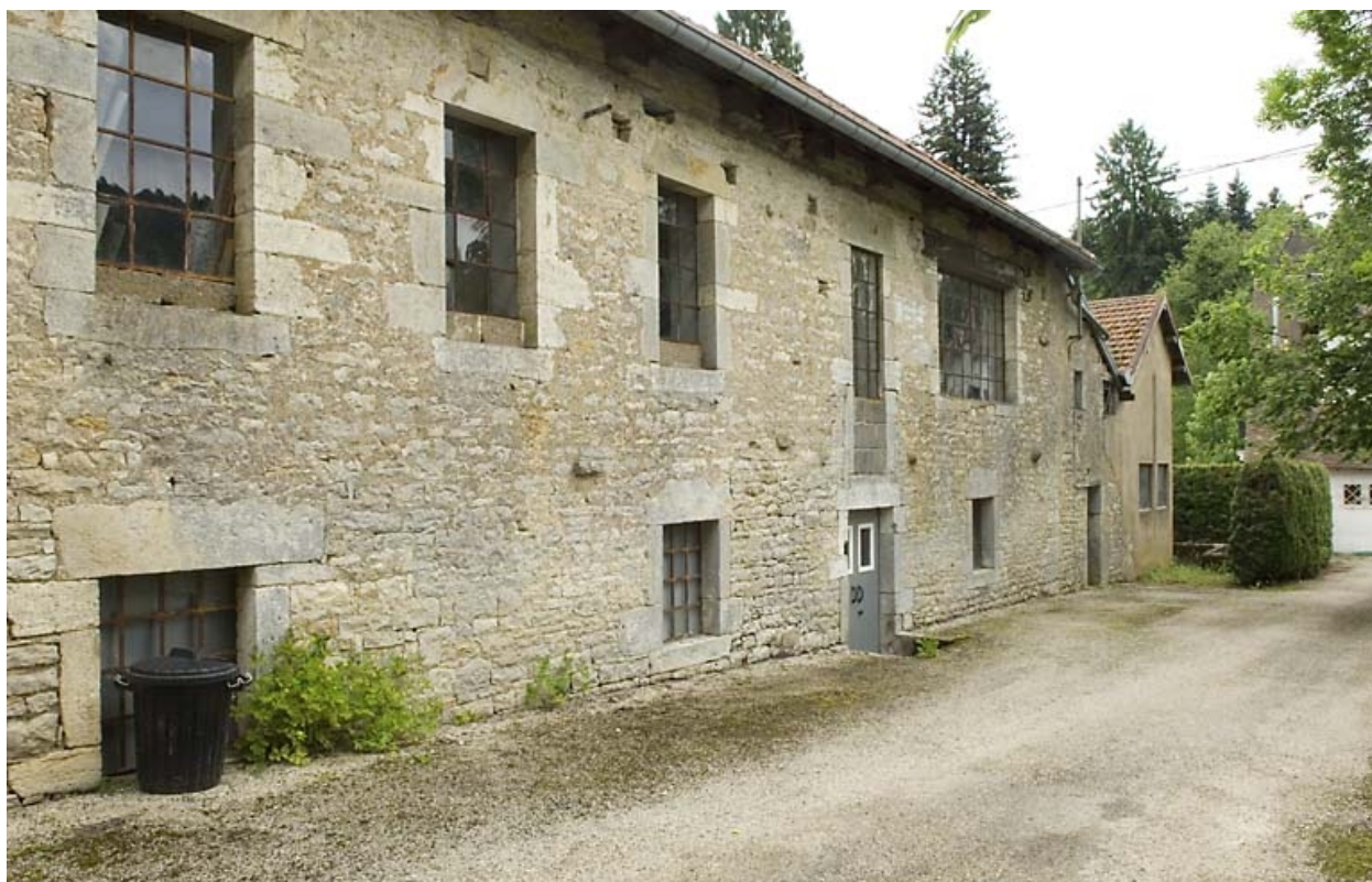
Façade ouest de l'atelier de fabrication.
