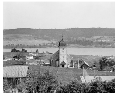
Vue sur la façade occidentale en 1981. Phot. Yves Sancey IVR43_19812500076X
