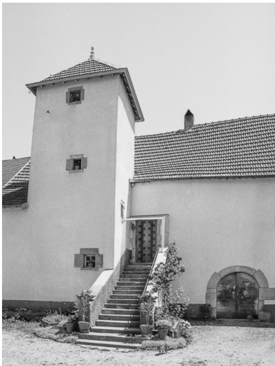
Détail : tour d'escalier et entrée de l'habitation.
