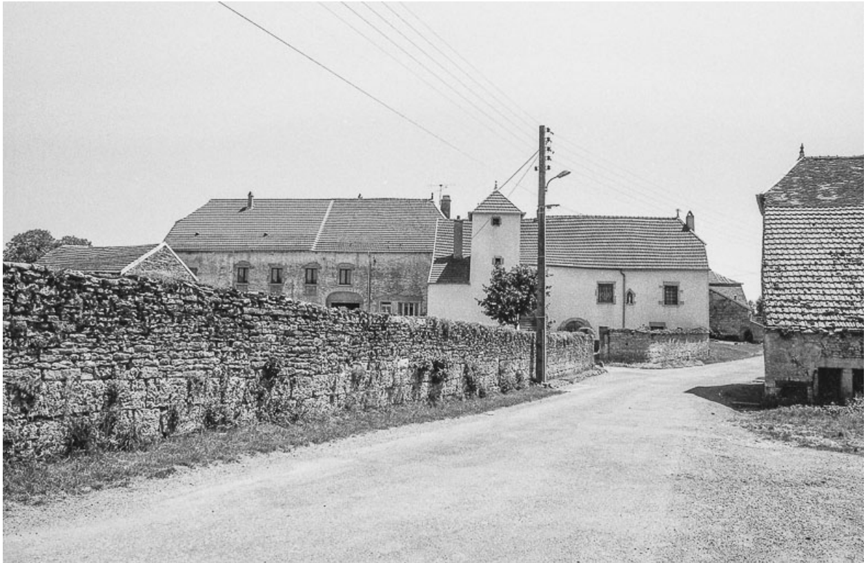
Vue éloignée du bâtiment depuis la rue.
