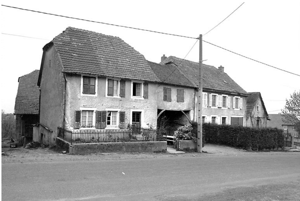
5e ferme : vue d'ensemble.
