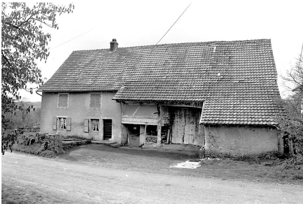
8e ferme : vue d'ensemble.
