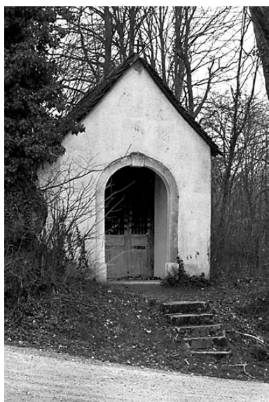
Oratoire : vue d'ensemble. Phot. Bernard Lardière IVR43_19829000319Z
