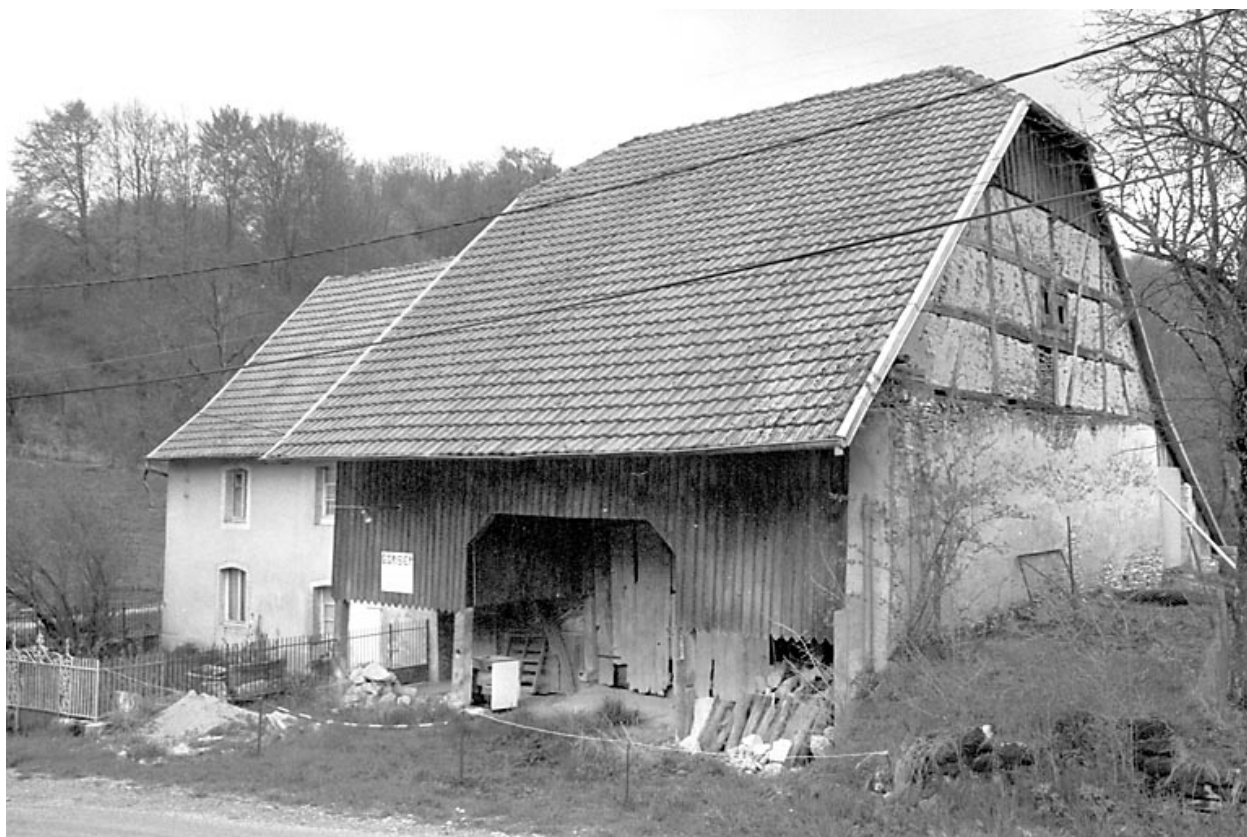
2e ferme : vue d'ensemble.
