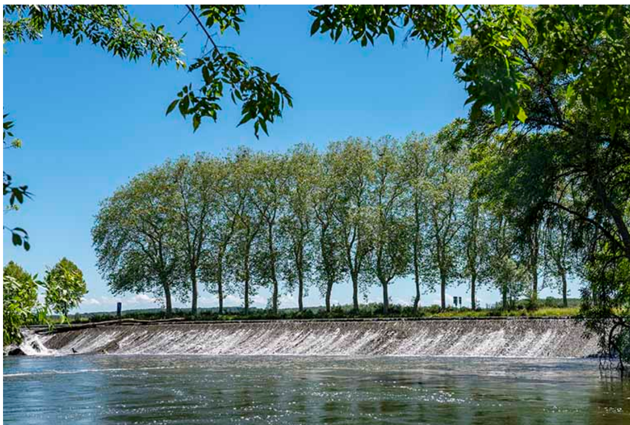
Déversoir en amont du barrage.
