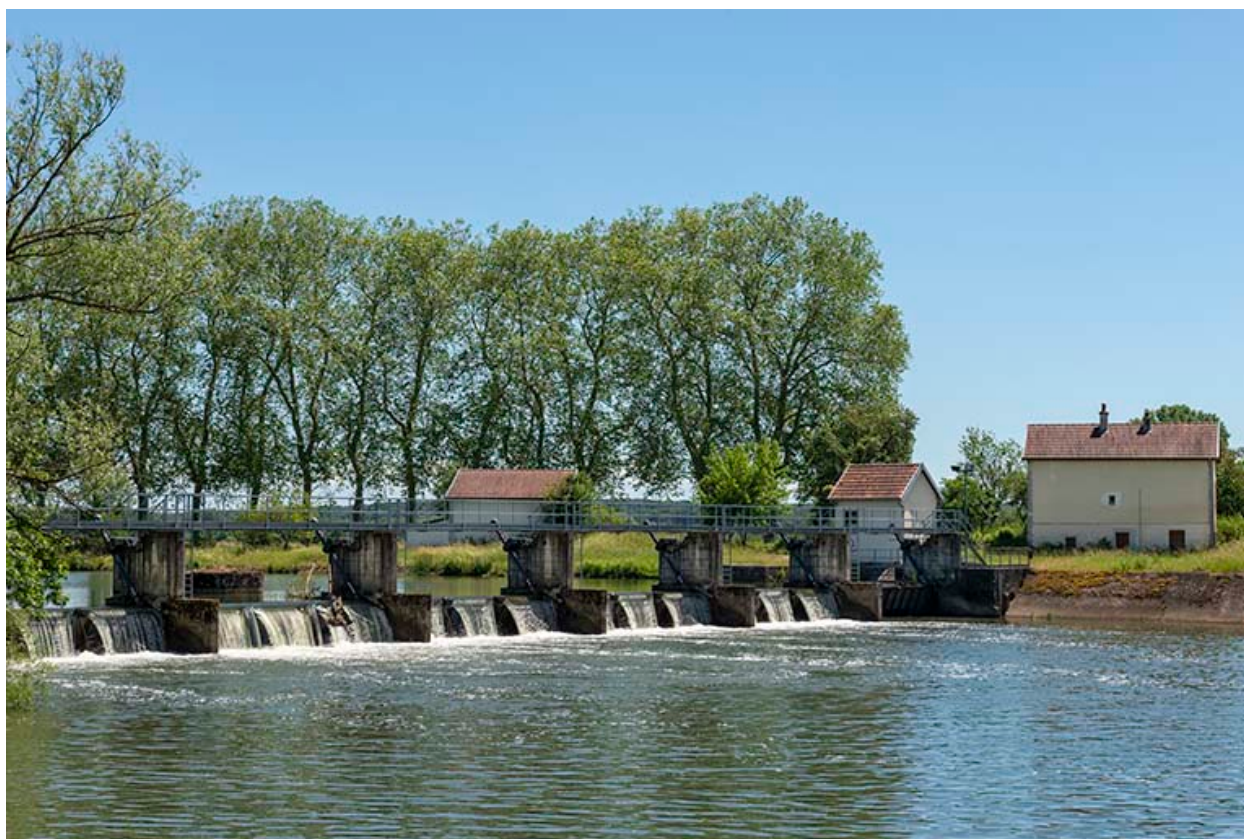
Vue depuis l'aval du barrage mobile.
