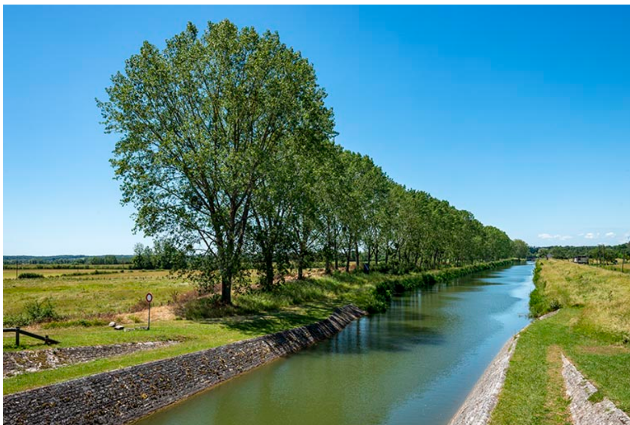
Le canal dans la dérivation.
