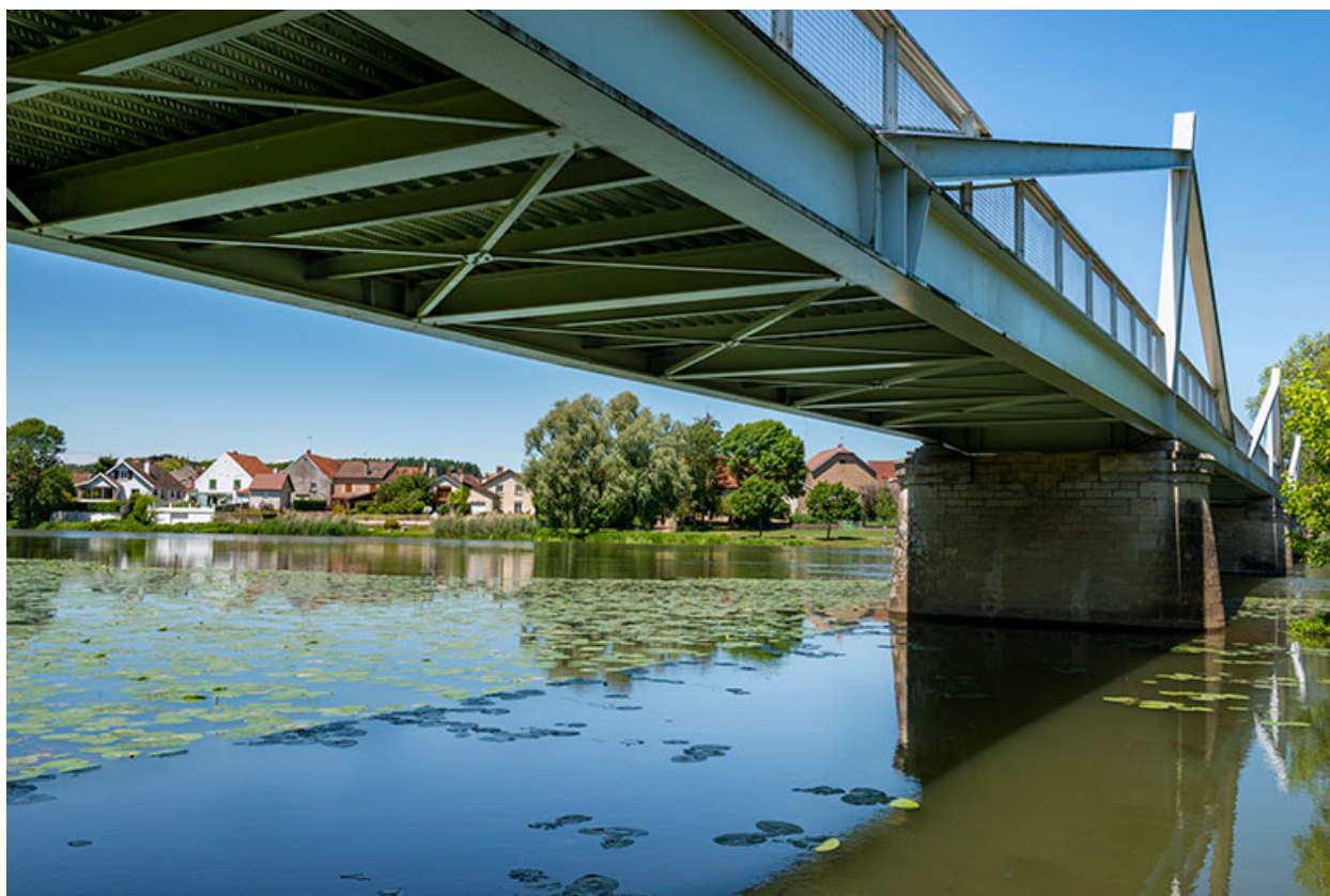
Tablier métallique du pont.
