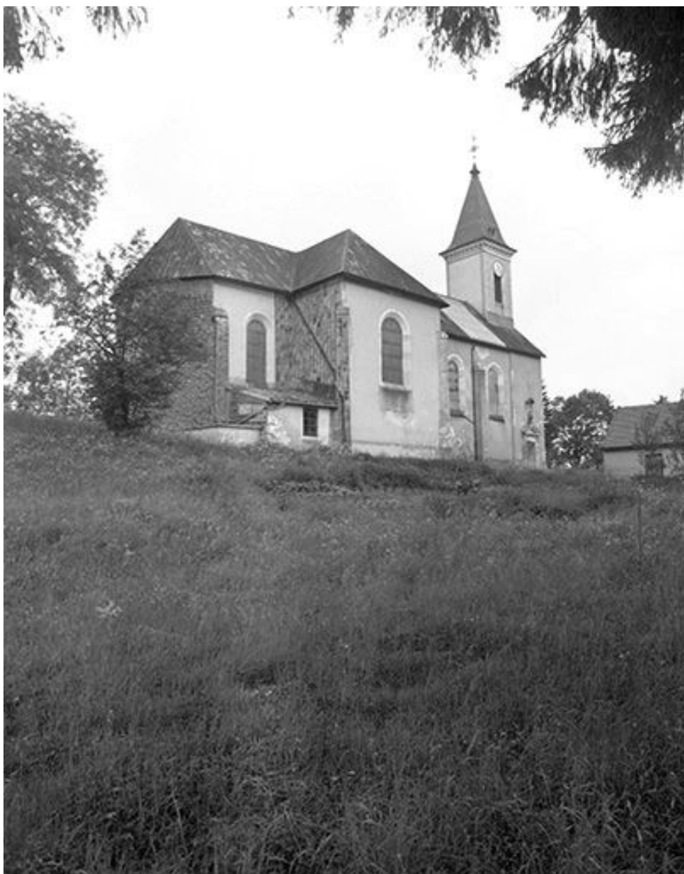
Façade latérale droite.
