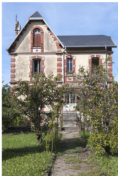
Façade postérieure. Phot. Jérôme Mongreville IVR43_20127000472NUC4A
