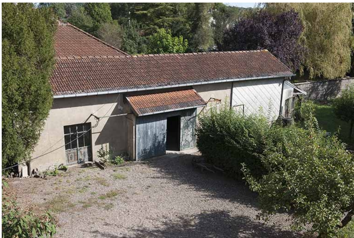
Vue générale de la remise.
